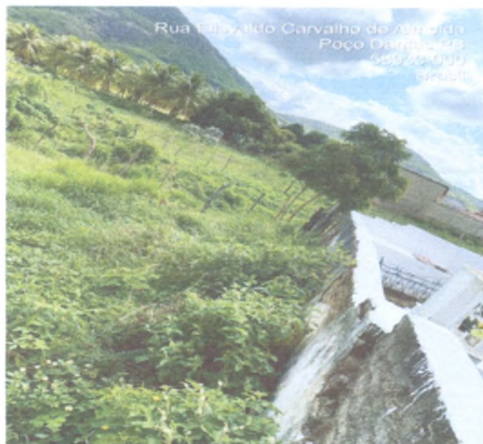
FOTO 04: Local da murada onde será demolido.
