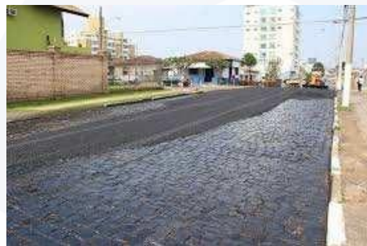
Figura 11: revestimento com pintura de ligação
