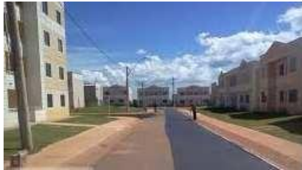
Figura 16: rejuvenescimento com micro revestimento asfáltico
