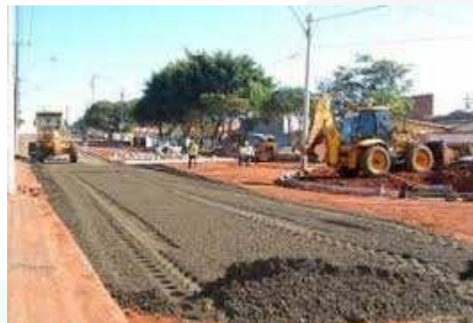
Figura 14: remoção e execução de base de brita graduada
