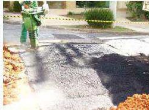
Figura 5: compactação do CA
