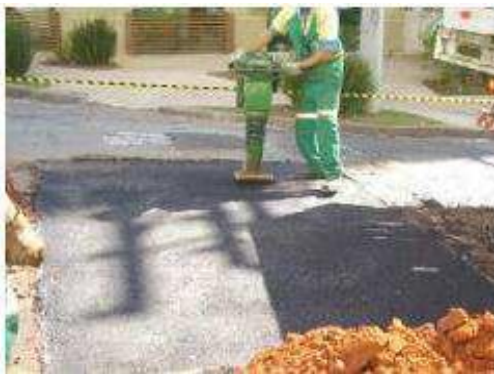
Figura 6: compactação do CA
