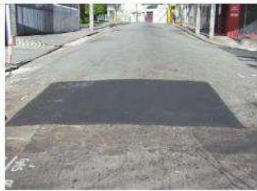
Figura 7: Remendo superficial executado
