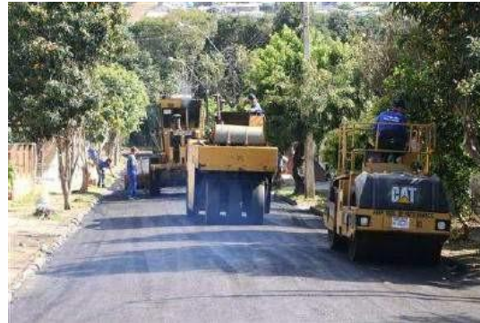
Figura 13: compactação do CA de reperfilagem
