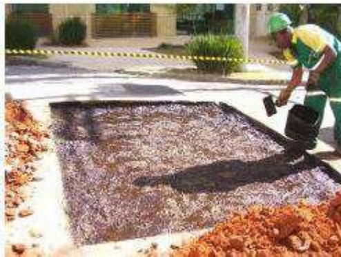
Figura 4: imprimação da camada de base
