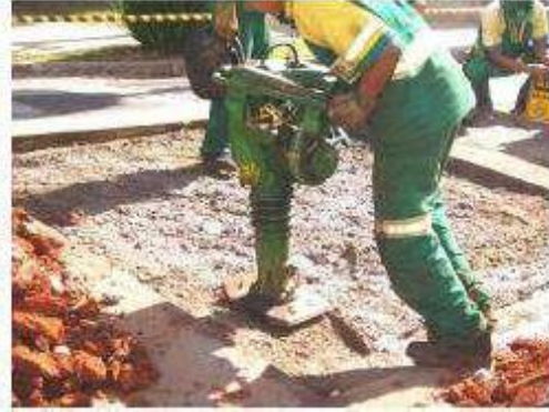
Figura 3: readequação da camada de base
