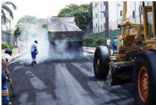
Figura 12: reperfilagem com CA
