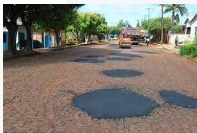
Figura 1: operação tapa buraco
