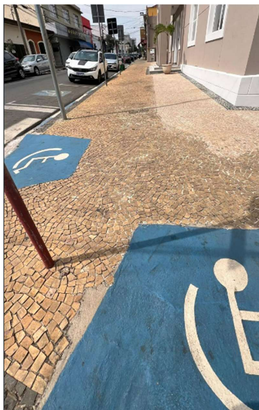
Visão da fachada lateral (Rua Tenente Gelás):
