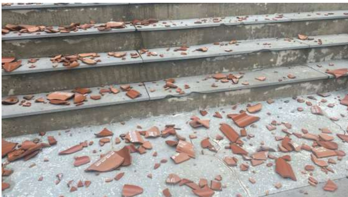
Entorno do Centro administrativo.
