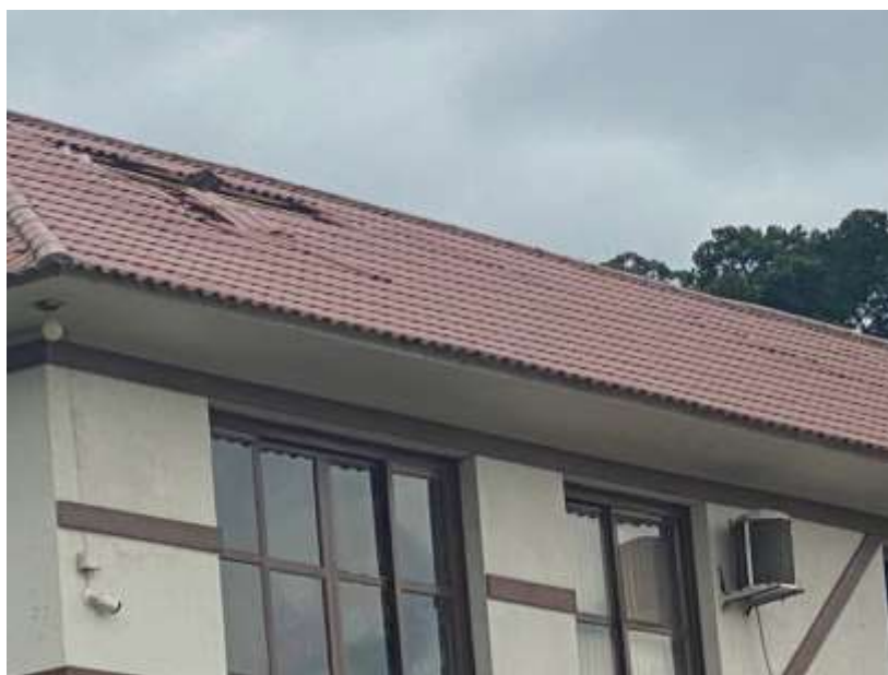
Telhado do Centro administrativo.
