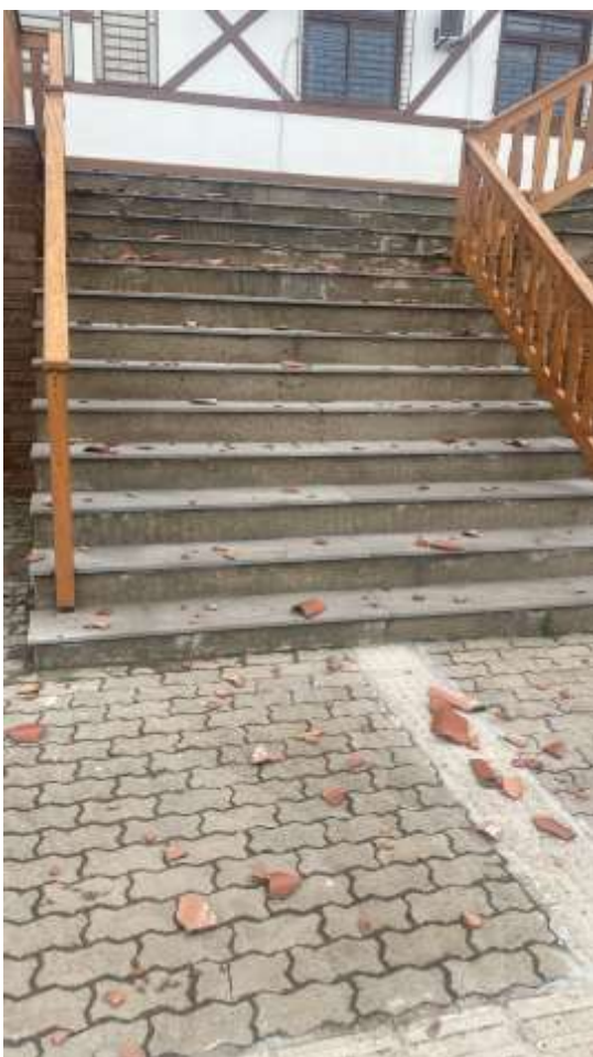
Entorno e estacionamento do Centro administrativo.
