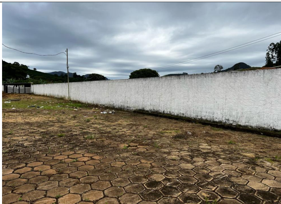
Descrição: FOTO 03 LOCAL DO BANHEIRO
