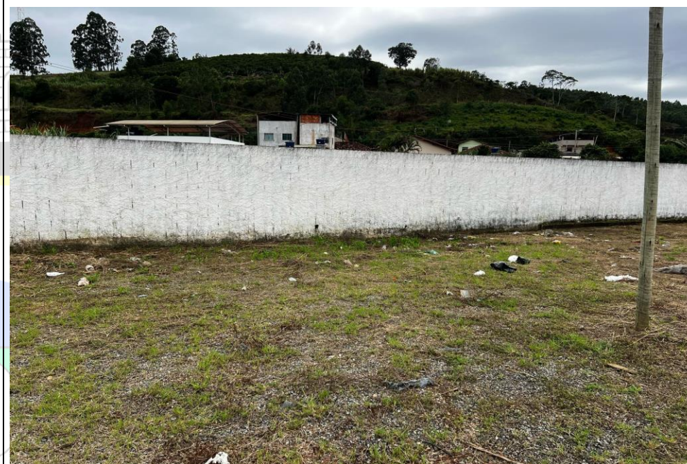
Descrição: FOTO 04 LOCAL DO BANHEIRO
