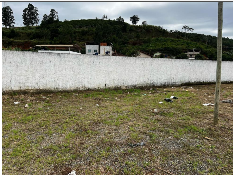
Descrição: FOTO 01 LOCAL DO BANHEIRO
