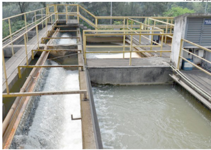
Após a conclusão, o fornecimento será restabelecido de forma gradual
