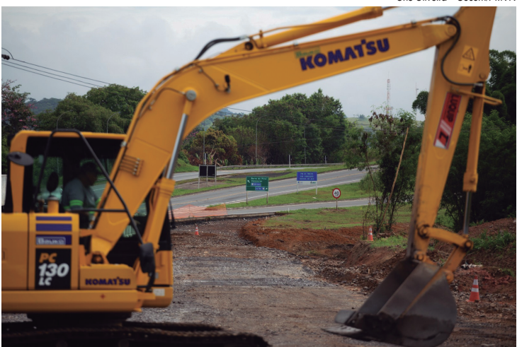
Obra atende a uma antiga demanda dos moradores e comerciantes do bairro, que buscavam um acesso mais seguro e eficiente
