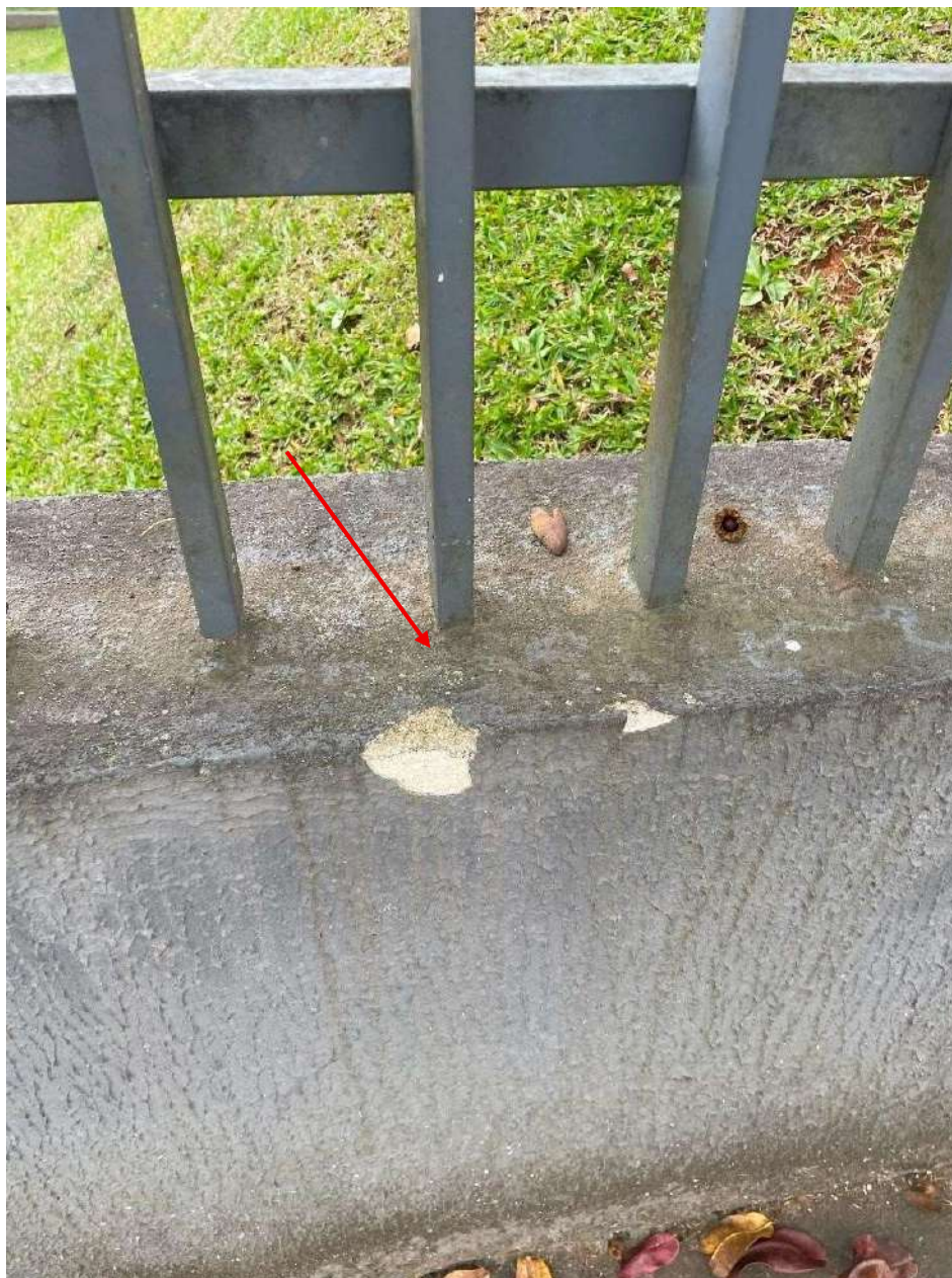
Fotografia 3 – Degradação e deslocamento de revestimento tipo emboço em mureta de alvenaria de vedação.
