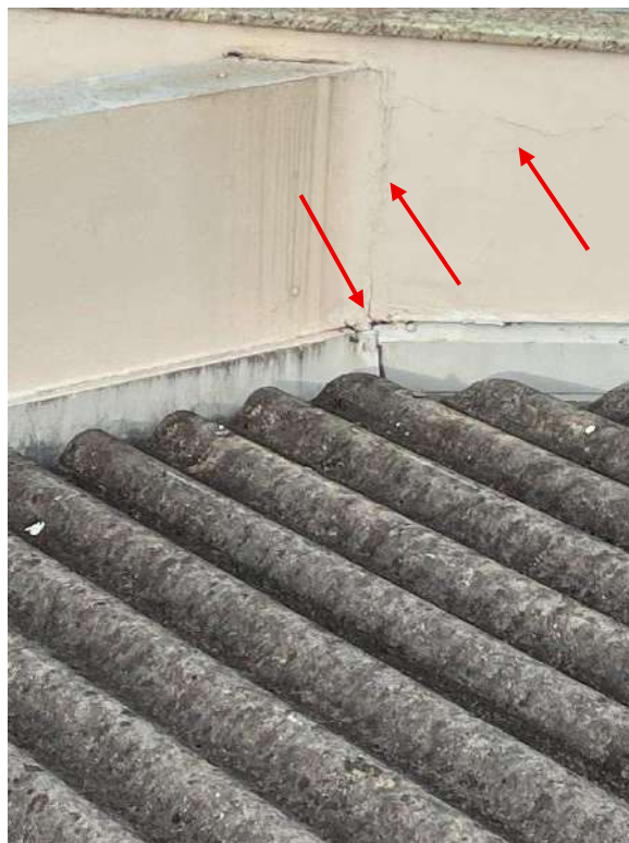
Fotografia 92 - Fissura por infiltração / Calha com falta de vedação
