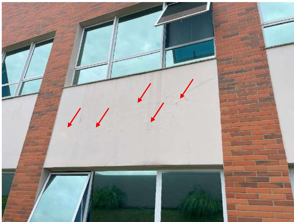
Fotografia 20 - Fissura por provável retração de argamassa / Infiltração Classificação: Vício, congênito / adquirido, endógeno.
