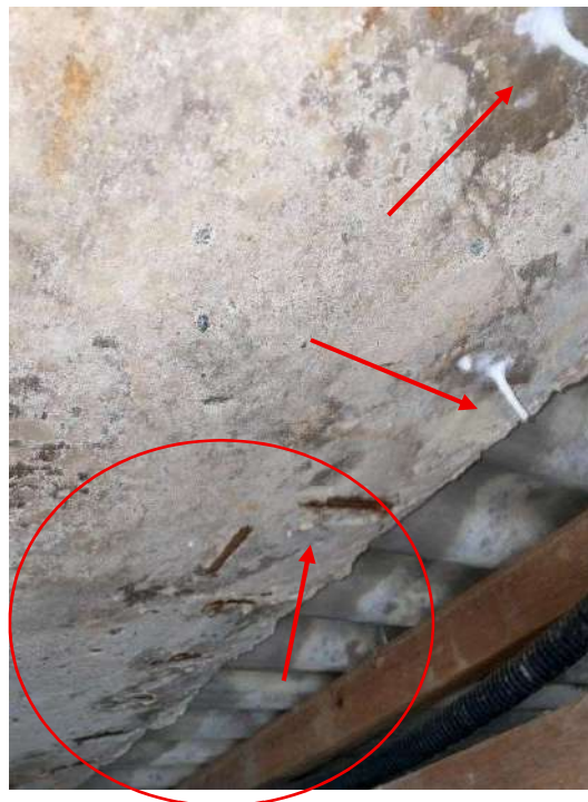
Fotografia 110 - Laje da caixa d'água apresenta sinais de eflorescência e aço exposto e corroído
