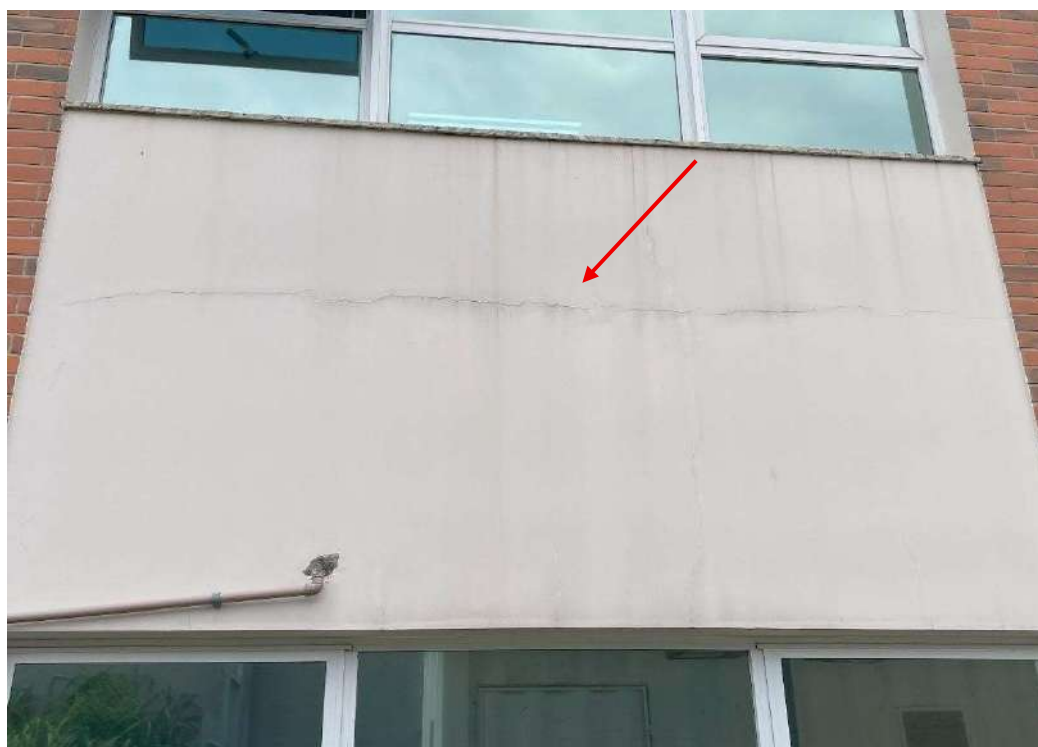
Fotografia 11 - Fissura por provável retração de argamassa / Infiltração
