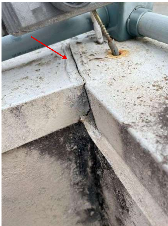
Fotografia 82 – Má vedação dos rufos Classificação: vício, congênito, endógeno.
