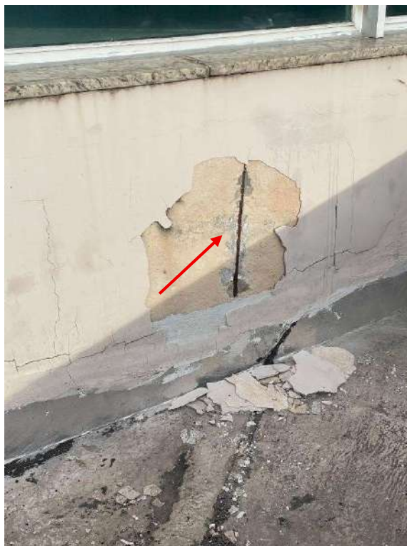
Fotografia 88 - Degradação da pintura e do emboço externo / aço do pilarete exposto e corroído
