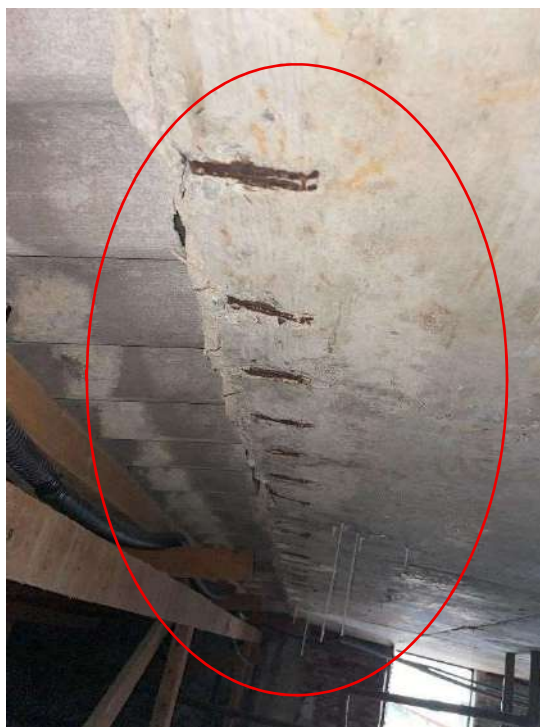
Fotografia 118 - Laje da caixa d'água apresenta sinais de eflorescência e aço exposto e corroído
