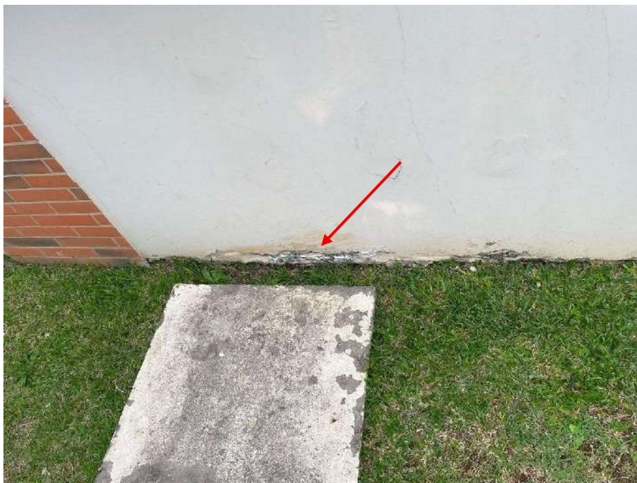
Fotografia 24 - Degradação e deslocamento de revestimento tipo emboço em rodapé de alvenaria de vedação.
