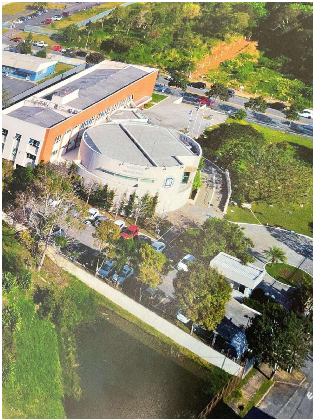
Fotografia 77 - Vista geral cobertura
