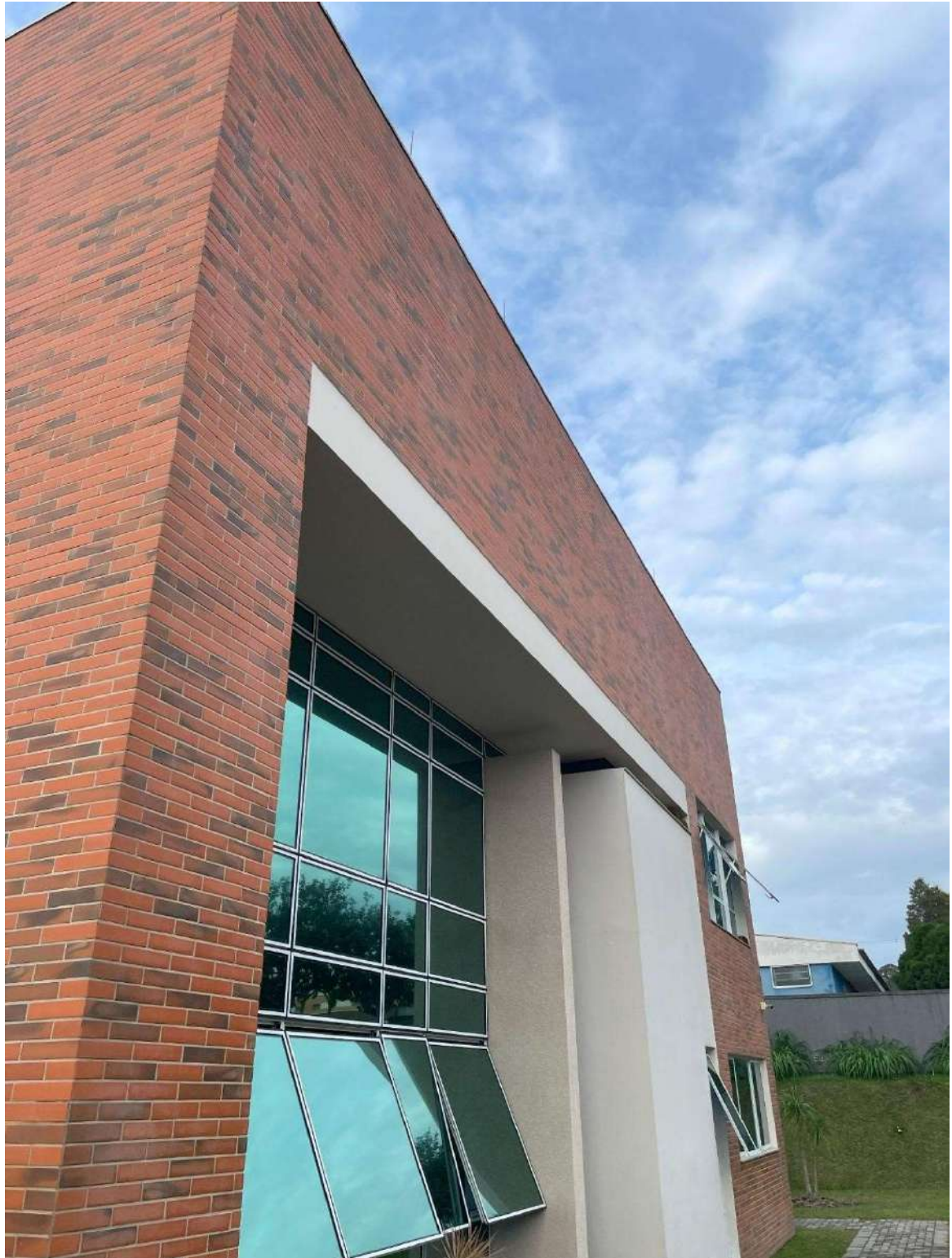
Fotografia 66 - Vista Geral fachada frontal
