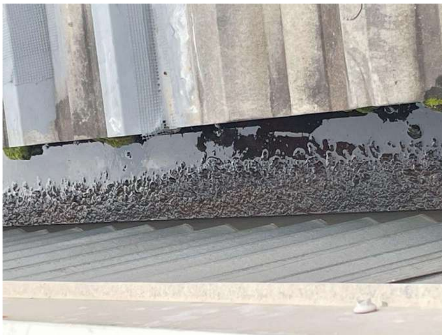
Fotografia 99 - Calhas com caimento irregular e presença de bolor
