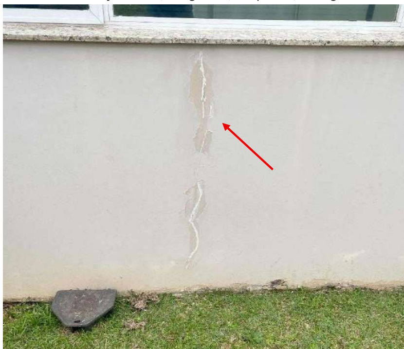
Fotografia 11 - Fissura por provável retração de argamassa / Infiltração
