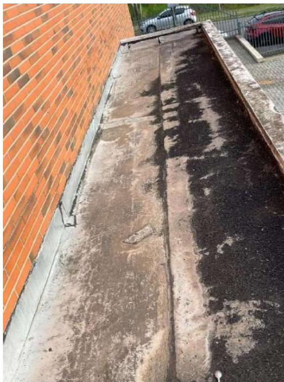
Fotografia 90 - Impermeabilização ineficiente; laje acima da laje em balanço na porta principal da CMCL.
