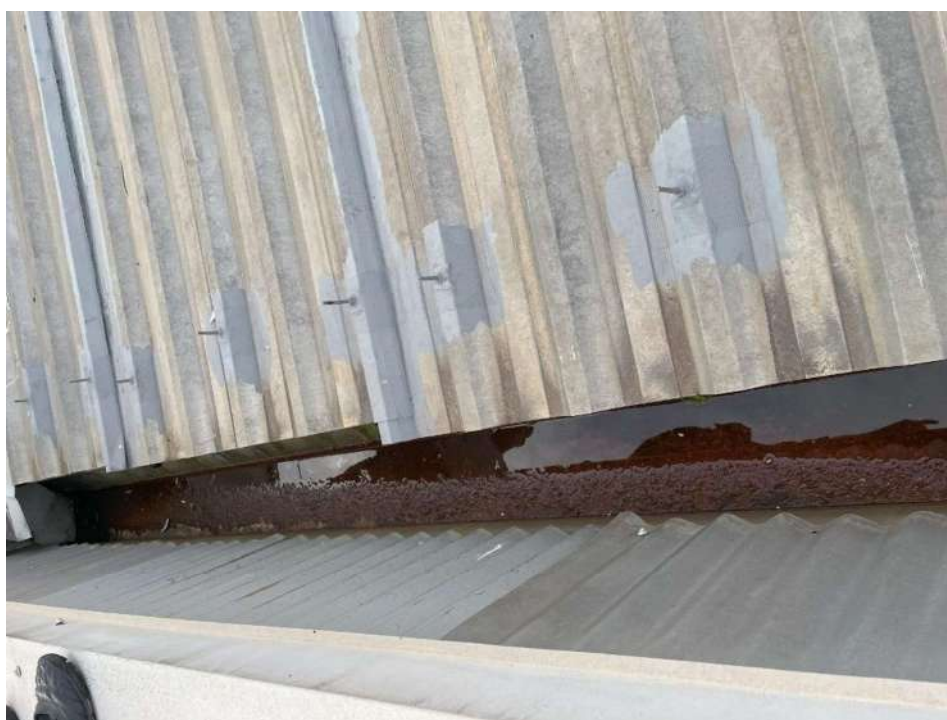
Fotografia 100 - Calhas com caimento irregular e presença de ferrugem
