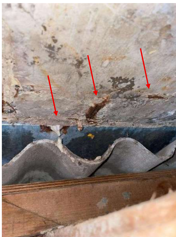
Fotografia 114 - Laje da caixa d'água apresenta sinais de eflorescência e aço exposto e corroído
