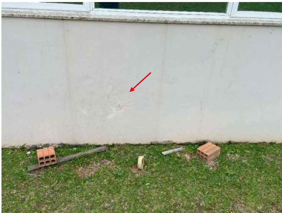
Fotografia 16 - Infiltração
