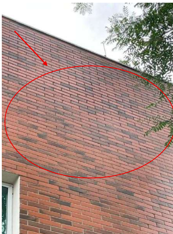
Fotografia 30 - Indícios de falha no rejuntamento e possível infiltração.
