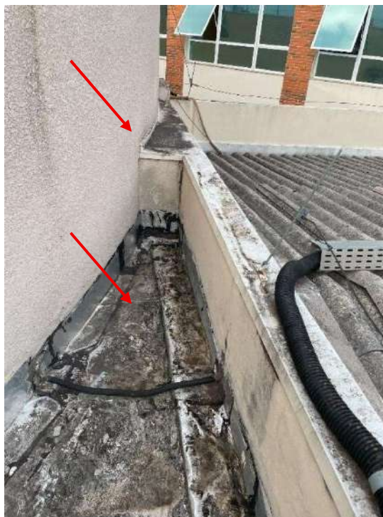
Fotografia 84 - Sistema de impermeabilização ineficiente / Rufos sem vedação adequada
