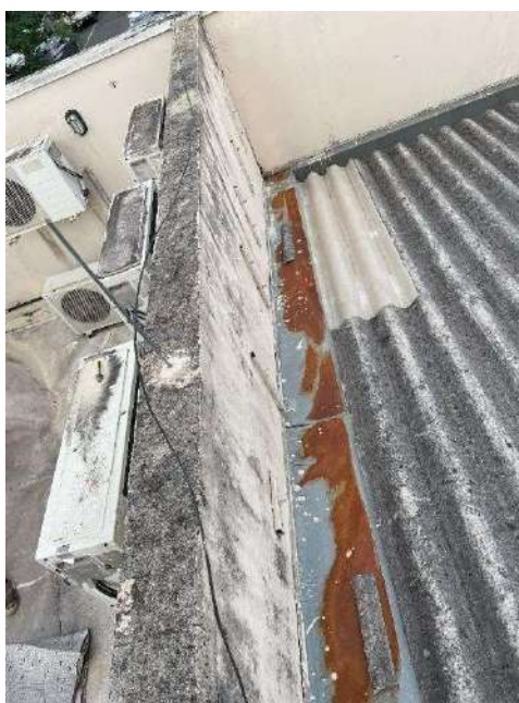
Fotografia 105 - Ferrugem e falta de vedação nos rufos e necessidade de pintura da platibanda
