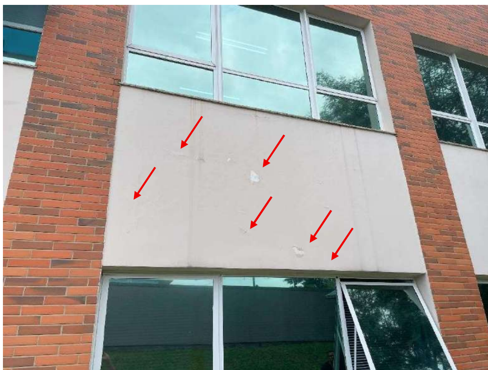
Fotografia 20 - Fissura por provável retração de argamassa / Infiltração Classificação: Vício, congênito / adquirido, endógeno.
