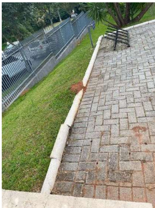
Fotografia 127 - Alinhamento de meio fio
