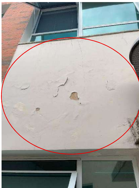
Fotografia 56 - Infiltração / Pulverulência de revestimento tipo emboço de fachada
