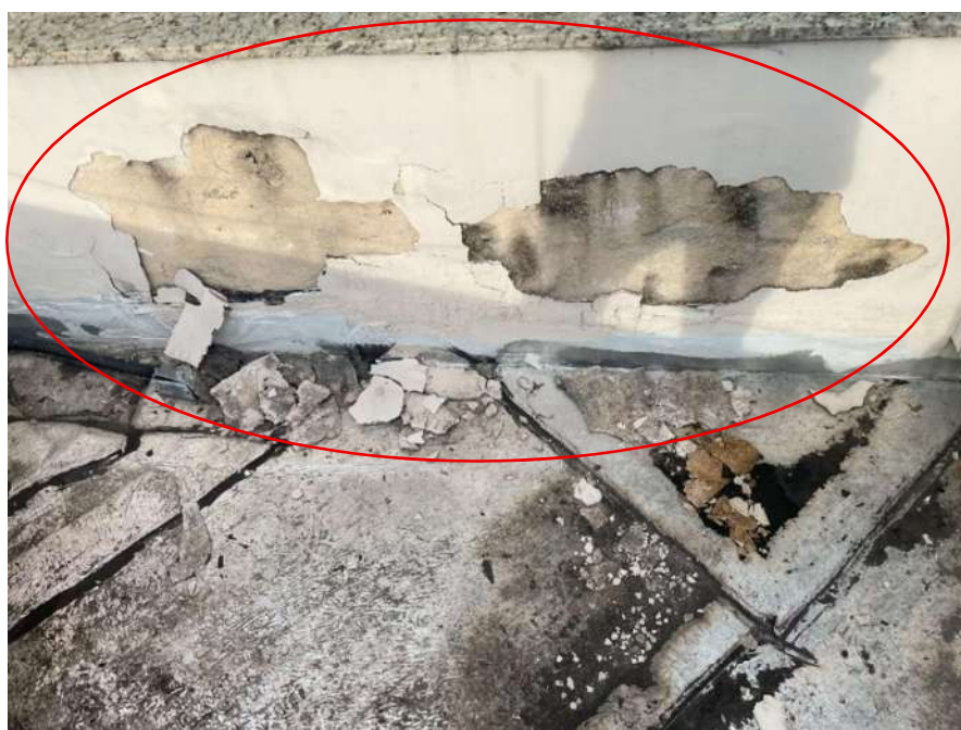
Fotografia 91 - fissuração e deslocamento do revestimento generalizada por infiltração
