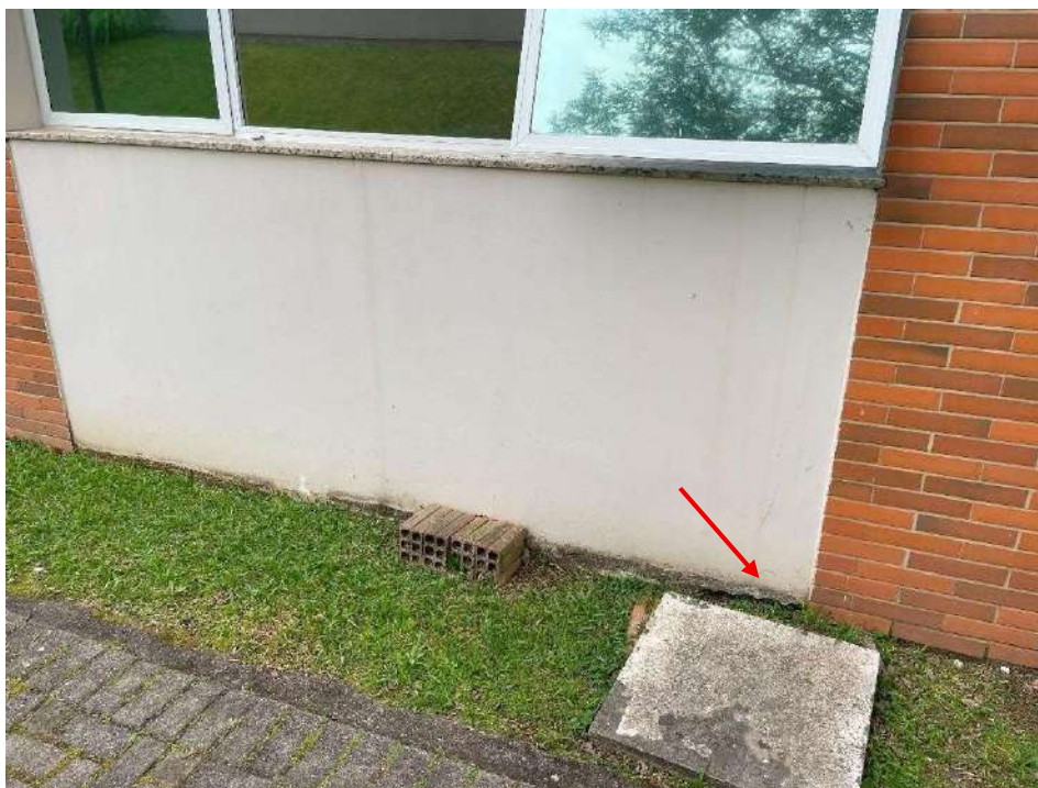
Fotografia 23 - Degradação e deslocamento de revestimento tipo emboço em rodapé de alvenaria de vedação.
