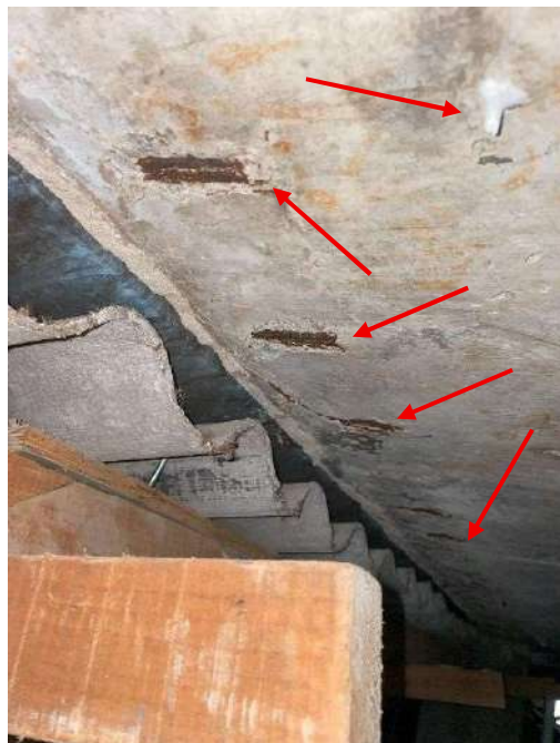
Fotografia 115 - Laje da caixa d'água apresenta sinais de eflorescência e aço exposto e corroído
