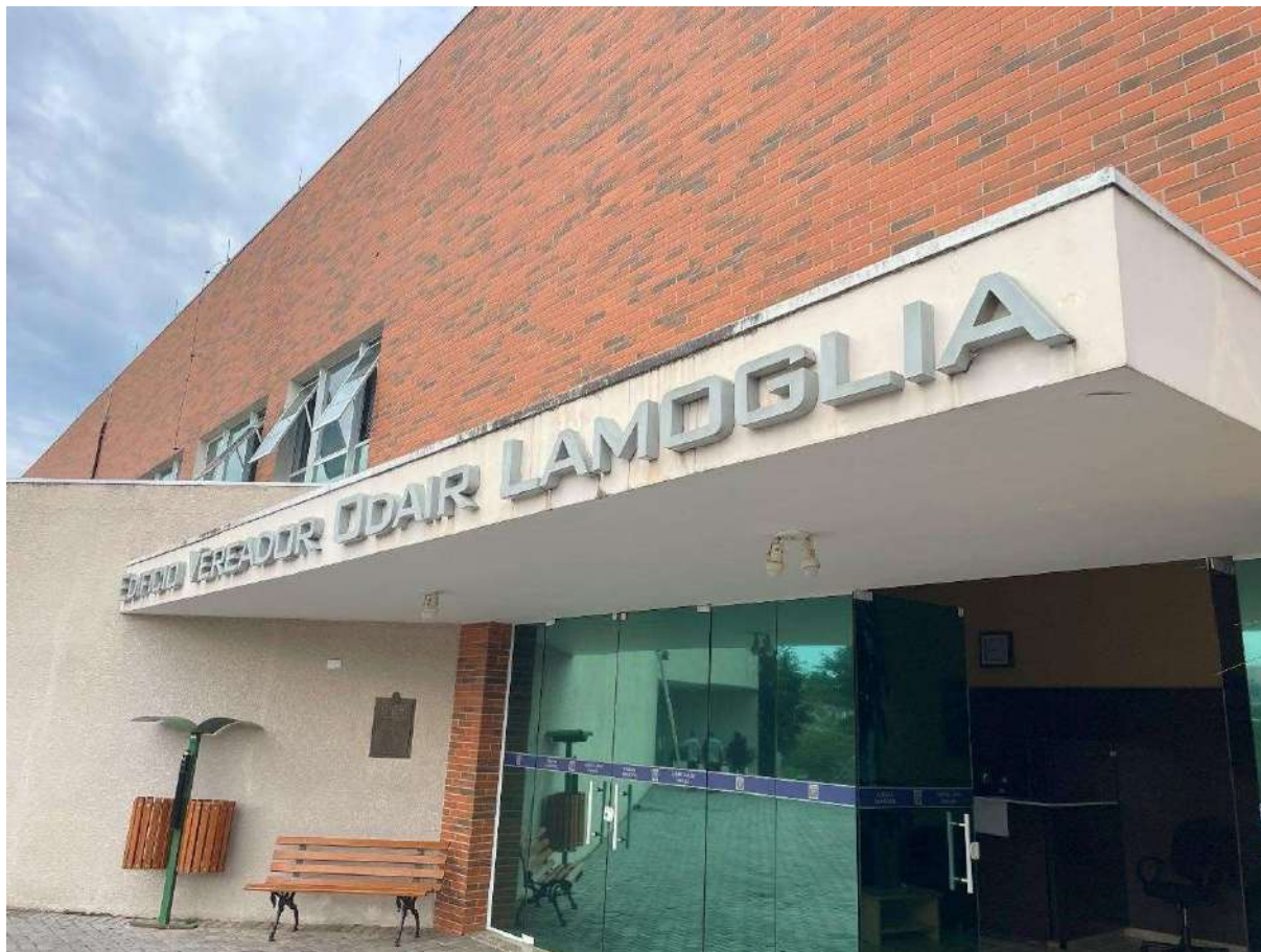
Fotografia 47 - Vista geral fachada 3
