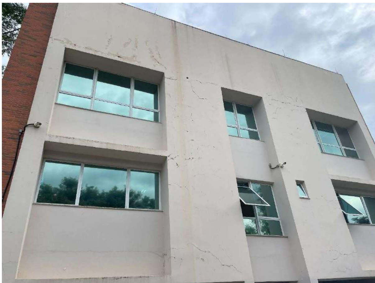
Fotografia 31 - Vista geral fachada posterior
