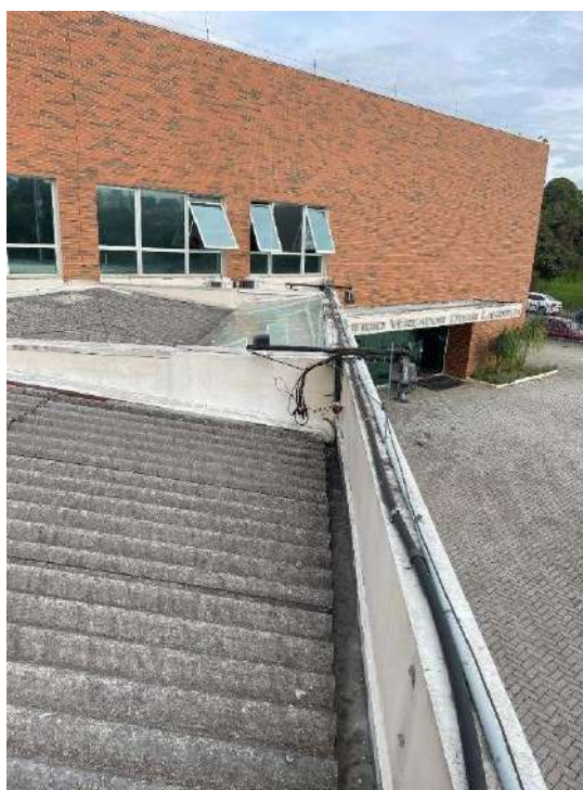
Fotografia 83 - Fixação do sistema SPDA / Falta de vedação dos rufos
