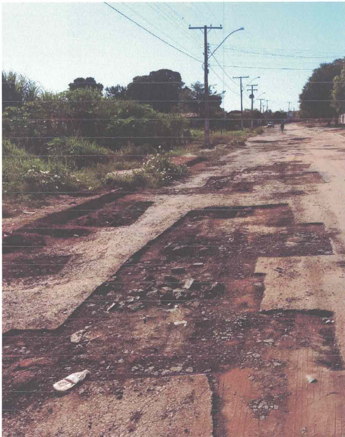
Foto 03. Seque o trabalho de recuperar a base para receber a massa CBUQ.
