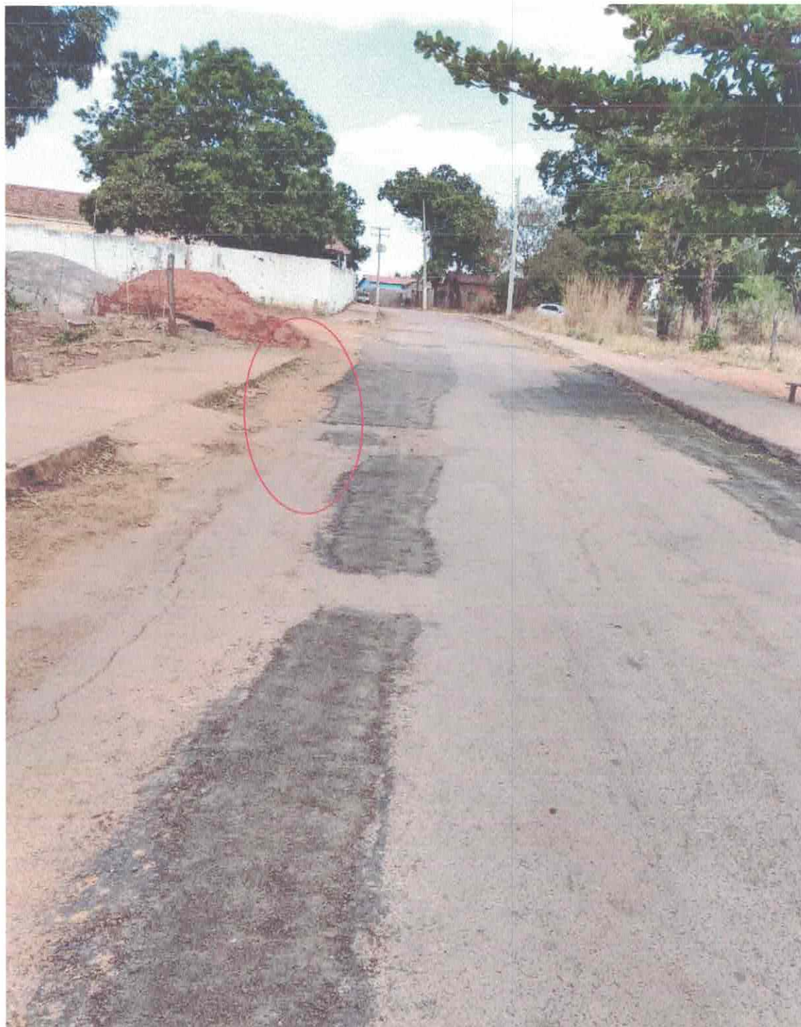
Foto 05. O tapa buraco está pronto depois da massa compactada mecanicamente.
