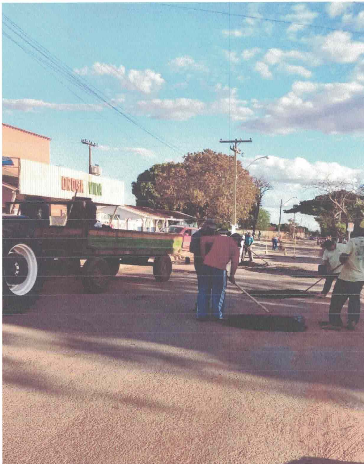
Foto 07. Os trabalhadores fazendo o Tapa buracos numa Avenida.
