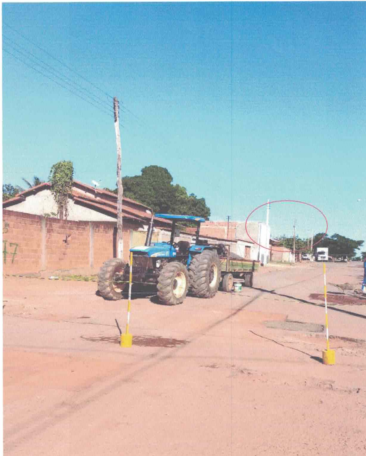
Foto 04. O Trabalho segue seguro e os trabalhadores protegidos na execução dos serviços.
