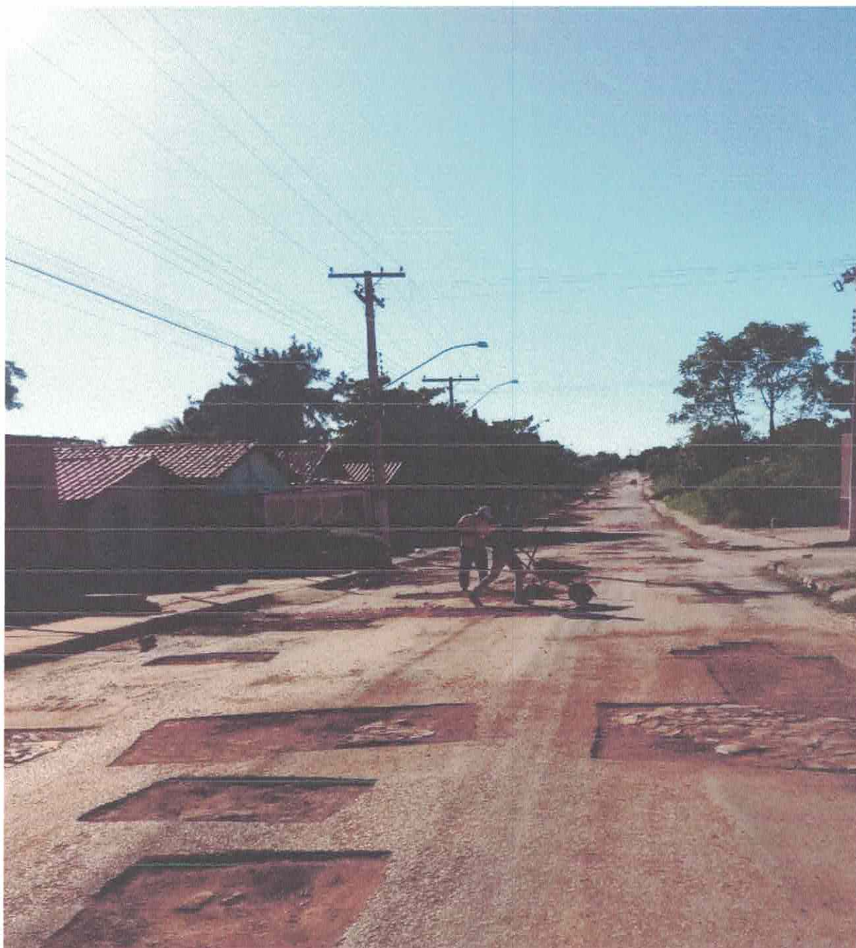
Foto 02. Começo do trabalho do tapa buraco esquadrejamento dos buracos e depois a colocação de cascalho compactado, ficando assim, a base pronta para receber a massa.
