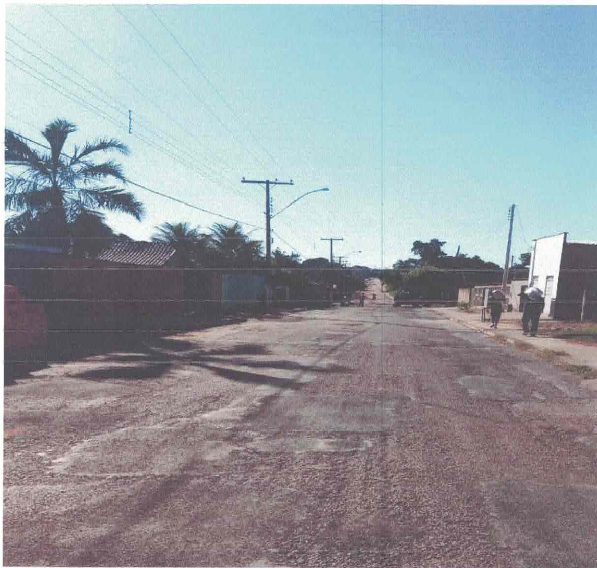
Foto 08. A Rua depois de pronta do tapa buraco e está aberta ao tráfego de veículos.
