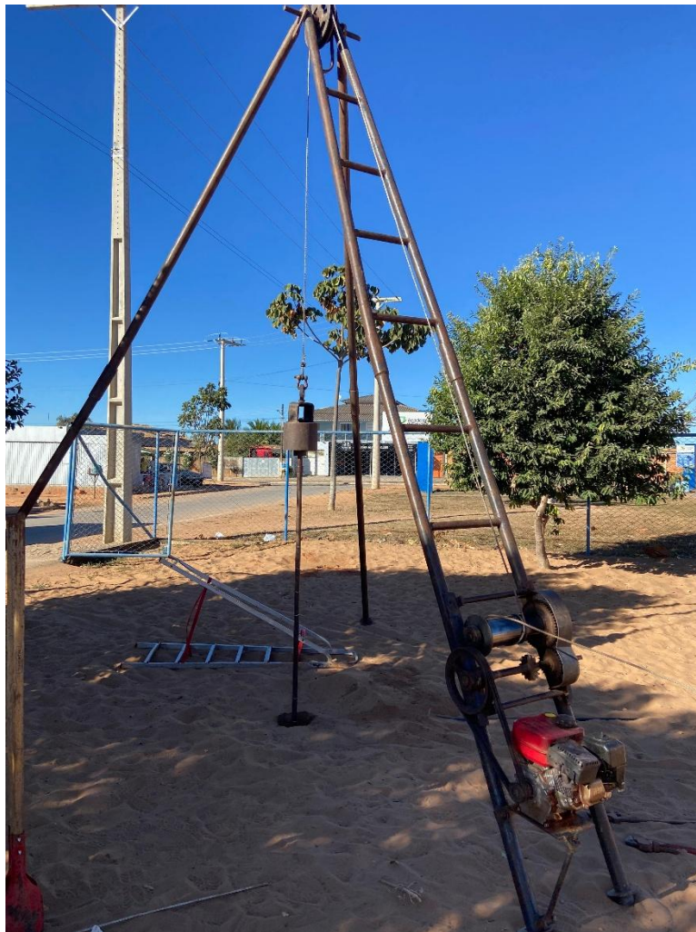
Instalação do Furo SP02
