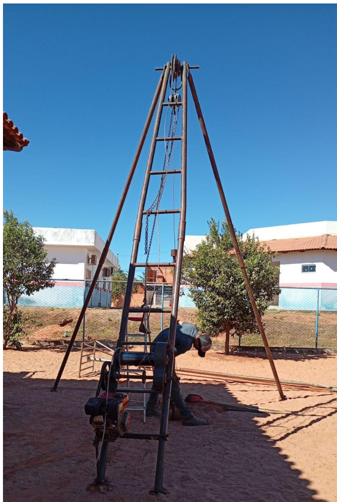
Instalação do Furo SP01
