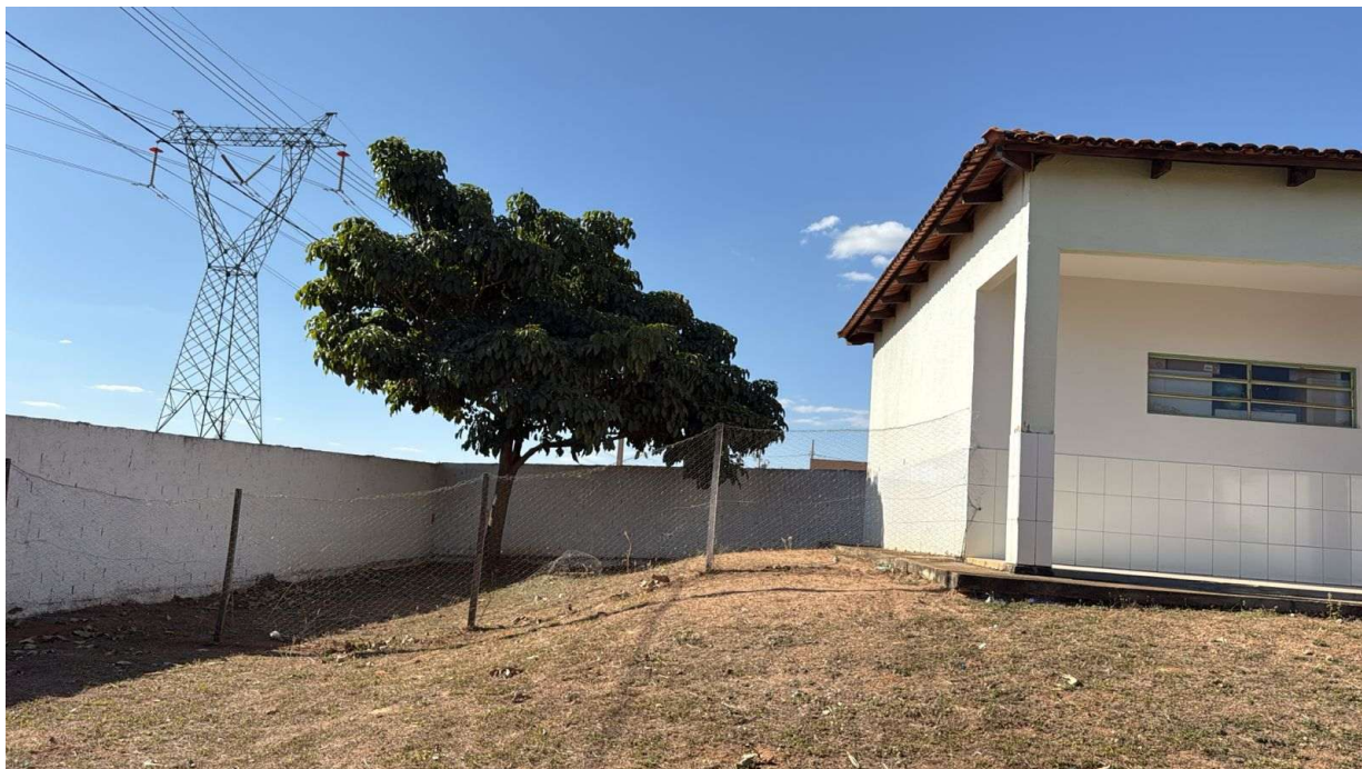
Imagem 01- local onde será construído a sala de aula.
