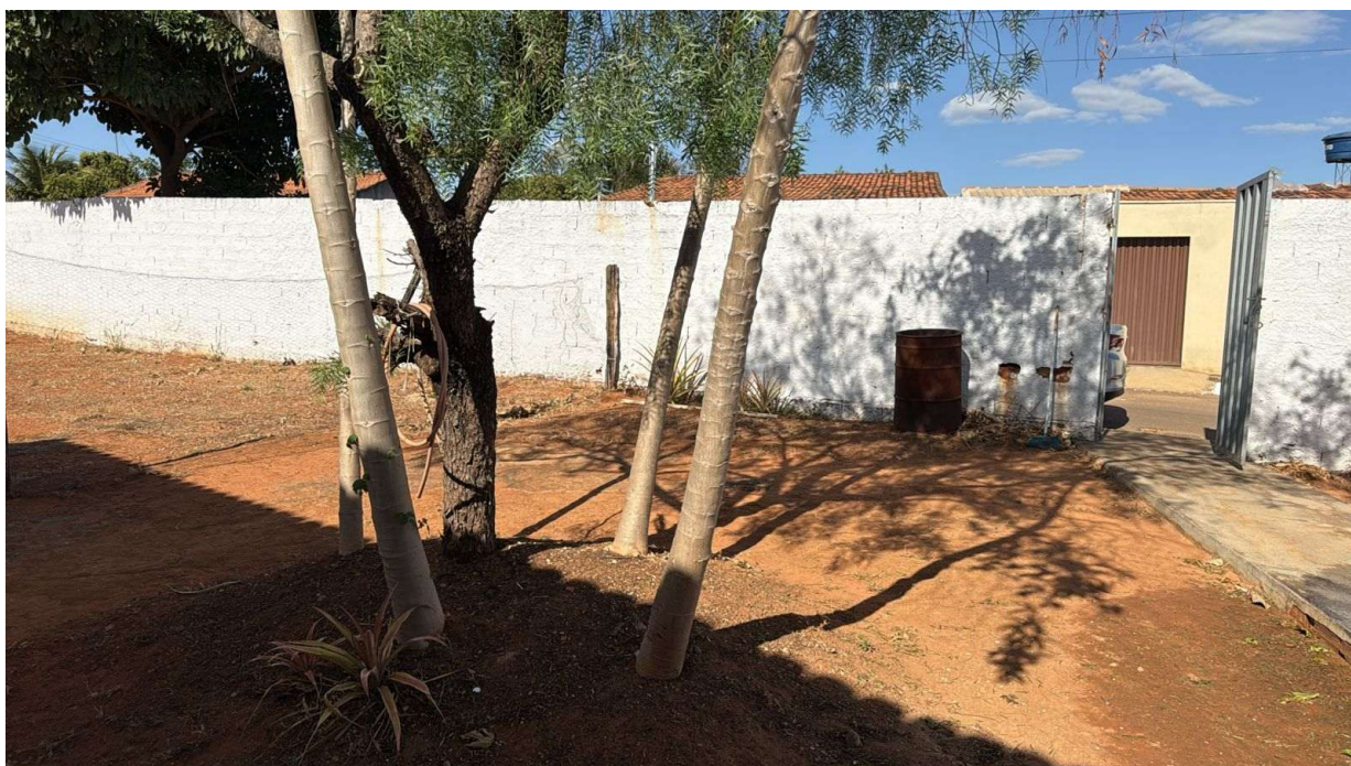
Imagem 02- local onde será construído o depósito.
