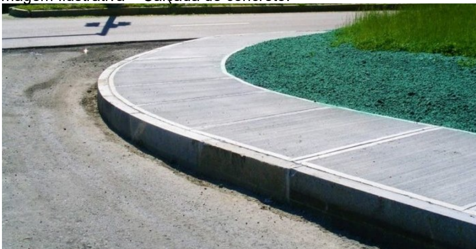
Imagem Ilustrativa – Calçada de concreto.
