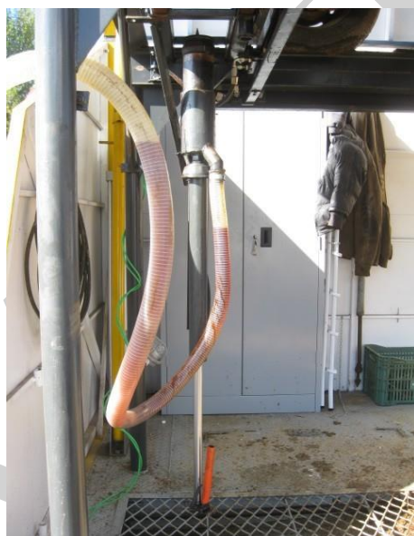
Fig.4 - Retirada de Combustível – Perfuração do Tanque;
