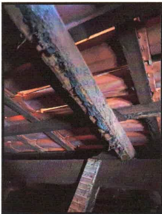
INFESTAÇÃO DE CUPIM NAS TERÇAS.
