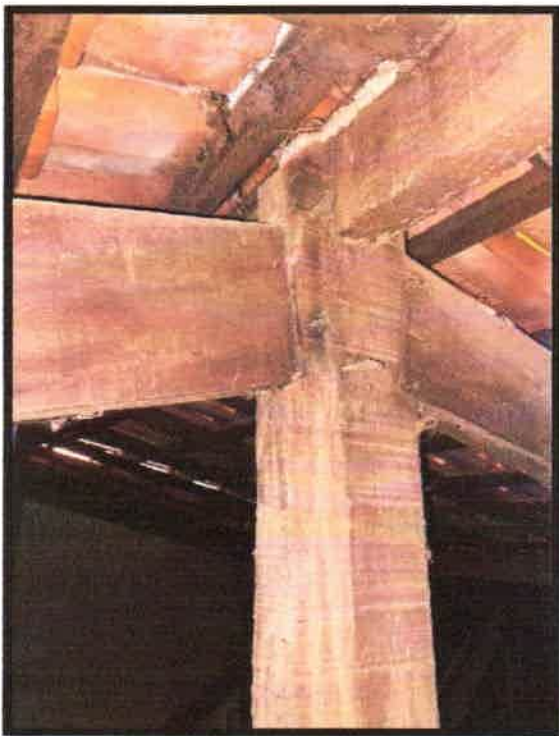
INFESTAÇÃO DE CUPIM APRESENTADA NAS UNIÕES ENTRE PERNAS E PENDURAIIS.
