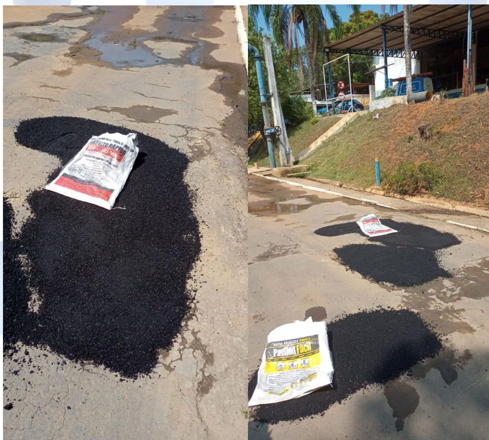
Foto – aplicação na ETA GÁVEA
