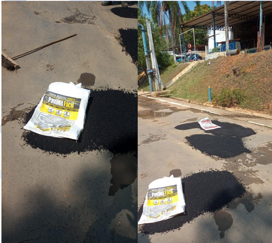
Foto – aplicação na ETA GÁVEA
