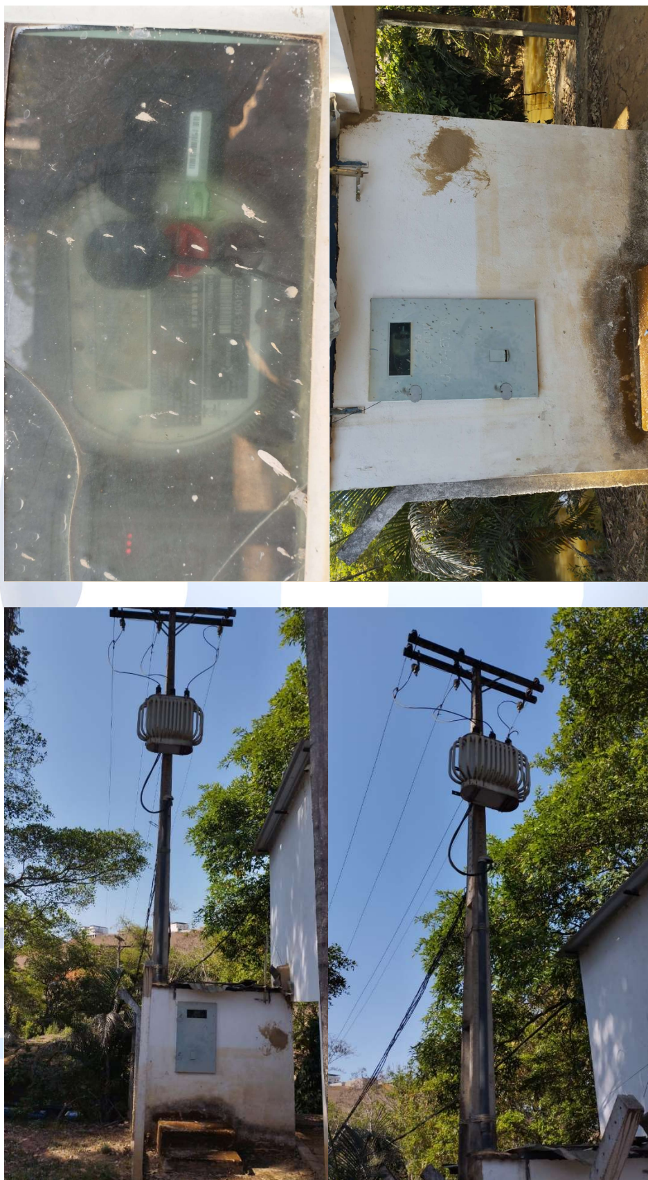
FOTOS DA UC DEMSUR RIO PRETO CAPTACAO – Coordenadas UTM: 769304.53 m E; 7662547.31 m S
