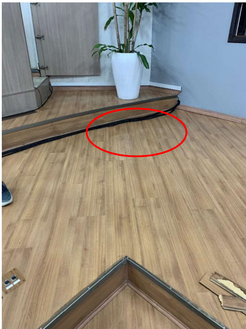
Figura 3 – Vista interna onde se observa pontos de umidade no piso.
