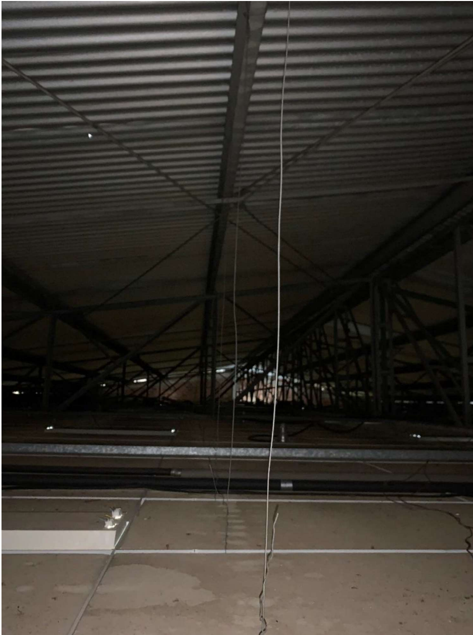
Figura 15 - Vista geral da estrutura metálica da cobertura
