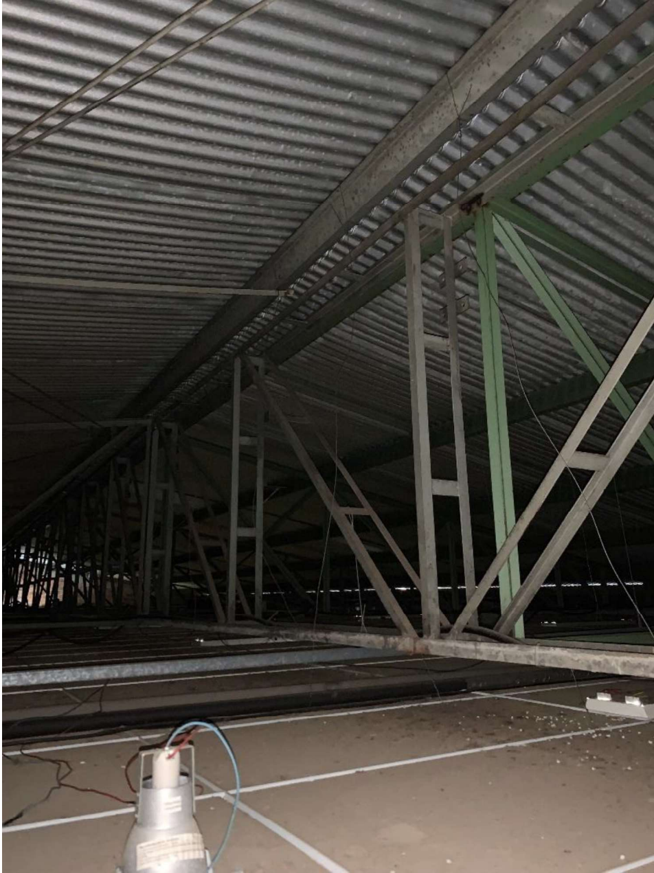
Figura 16 - Vista da treliça central da estrutura metálica da cobertura
