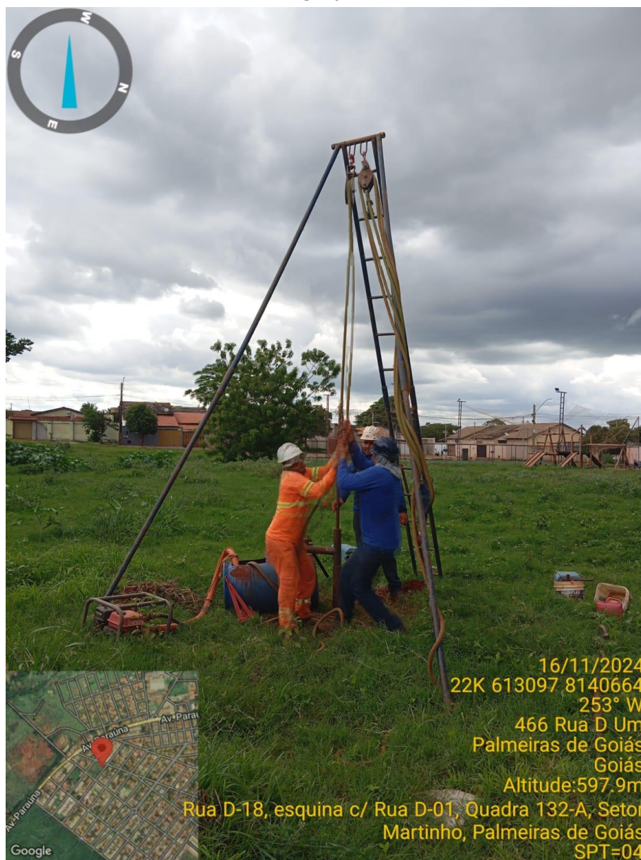
Instalação do furo SP-04
