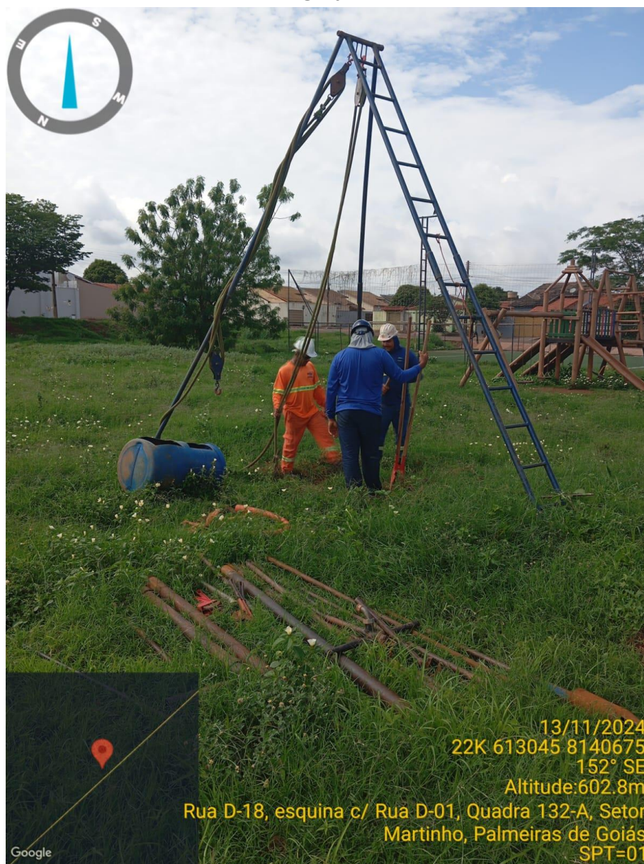
Instalação do furo SP-01
