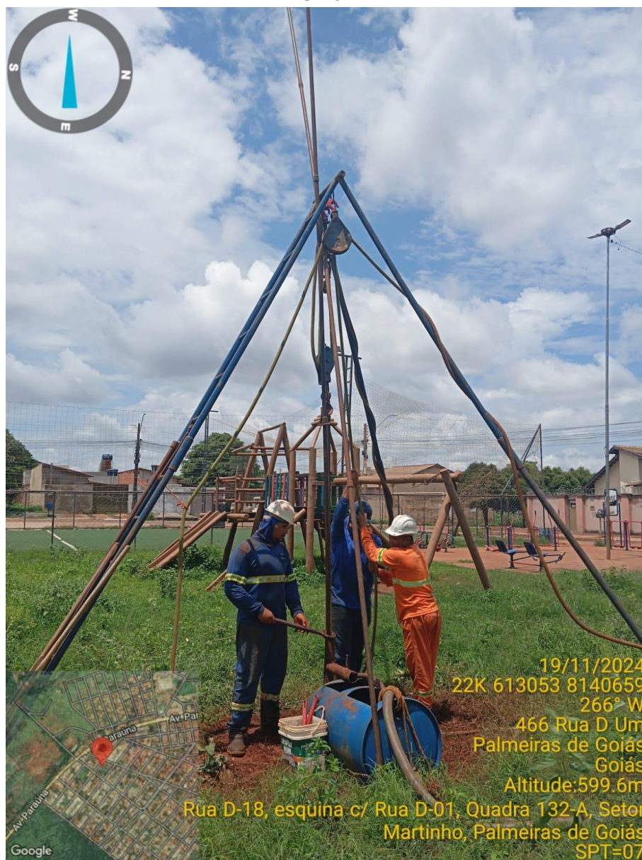
Instalação do furo SP-07
