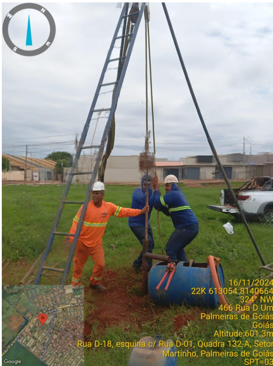
Instalação do furo SP-03
