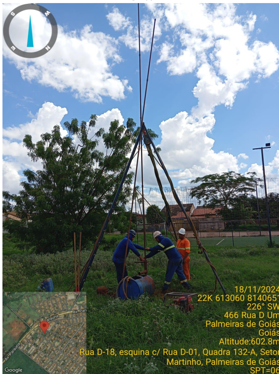
Instalação do furo SP-06
