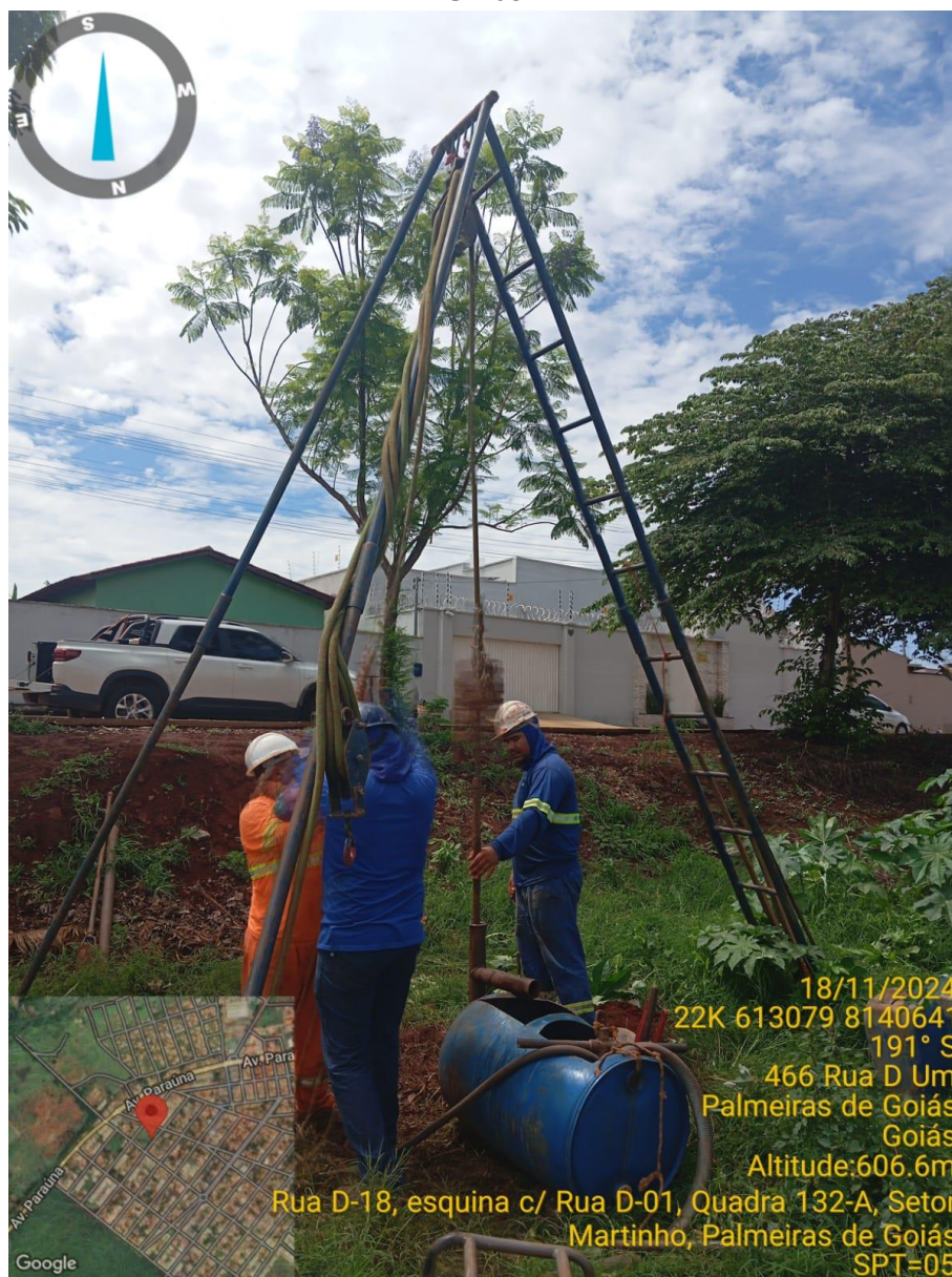
Instalação do furo SP-05
