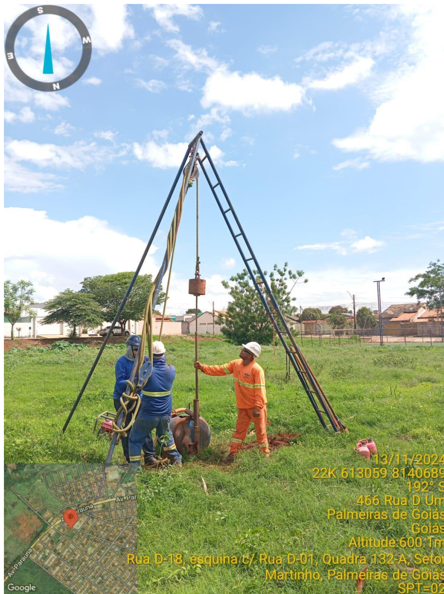
Instalação do furo SP-02
