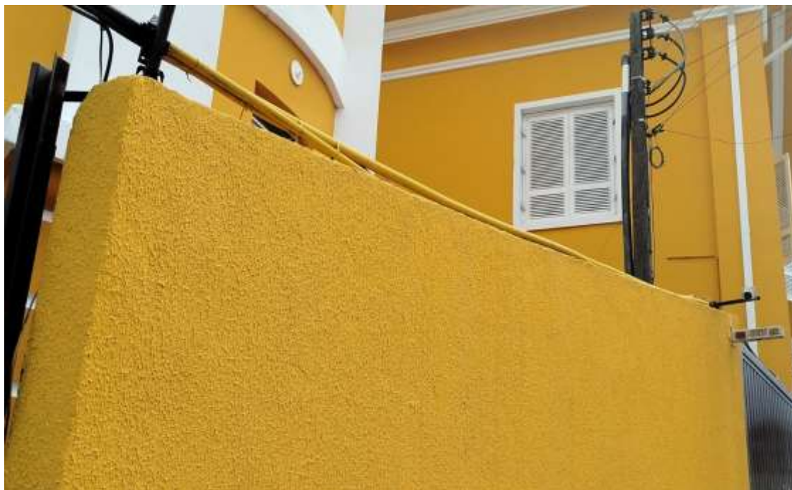
Figura 08 – Muro cercamento gerador
