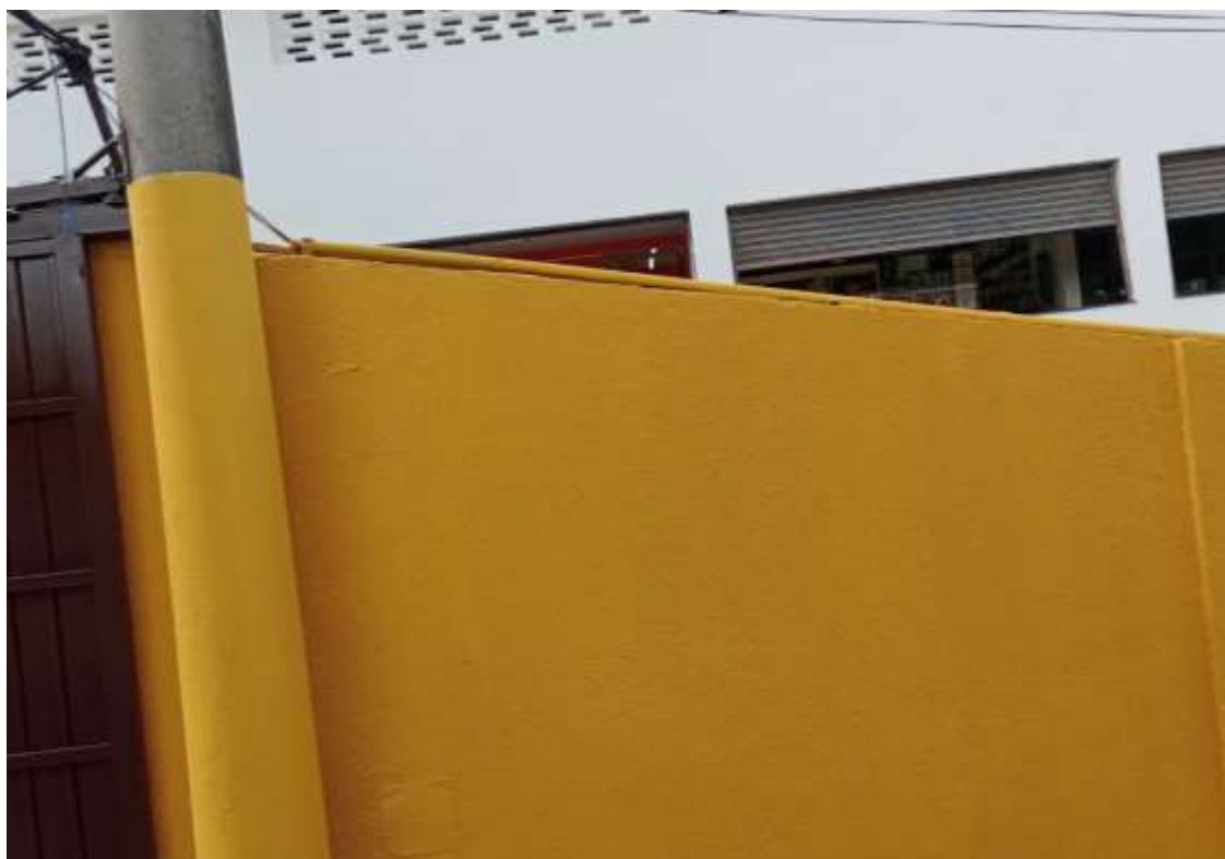
Figura 02 – Muro entre portões
