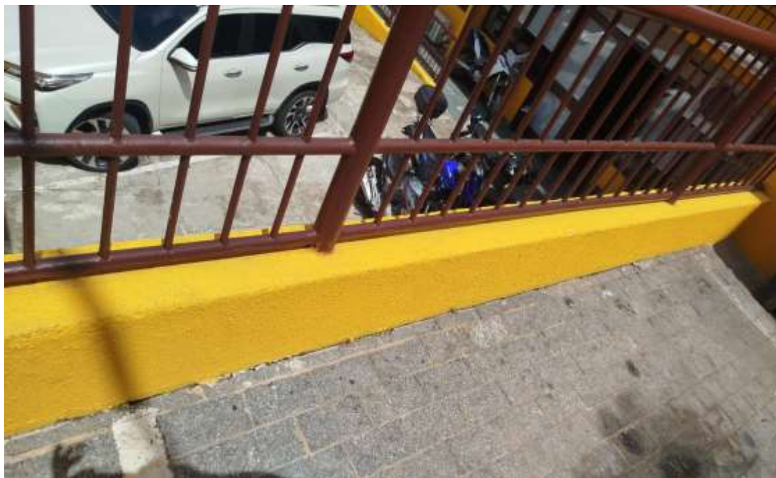
Figura 01 - Mureta com gradil
