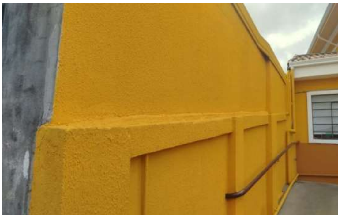
Figura 07 – Muro de contenção
