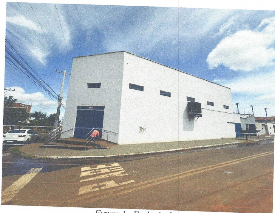
Figura 1 - Fachada do Imóvel
