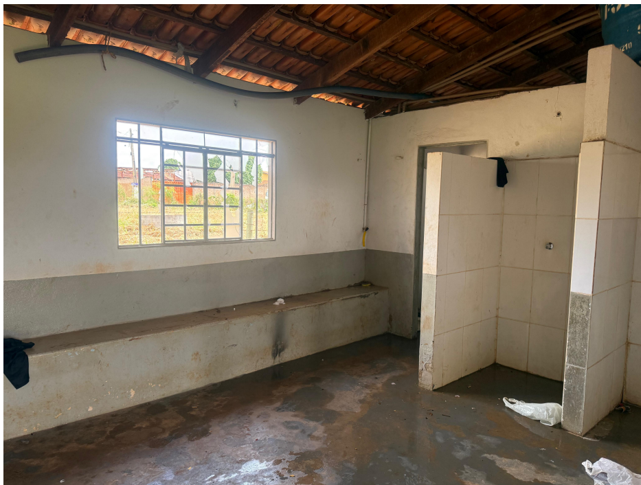
Imagem 04 - Além das questões já apontadas na imagem anterior, nessa pode-se ver também a janela em estado recário quanto a segurança e sua função.
