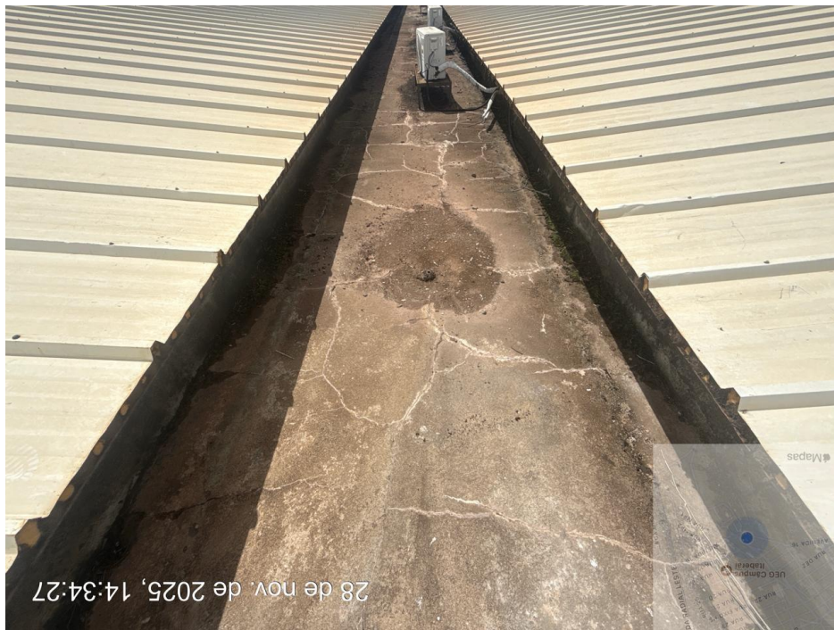
Imagem 5 - Situação atual da laje técnica de cobertura, com numerosas fissuras qu comprometem a estanqueidade do elemento.
