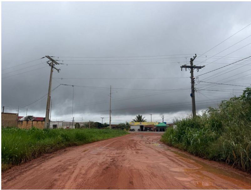
Imagem 01 - Via não pavimentada com acúmulo de água em período chuvoso.
