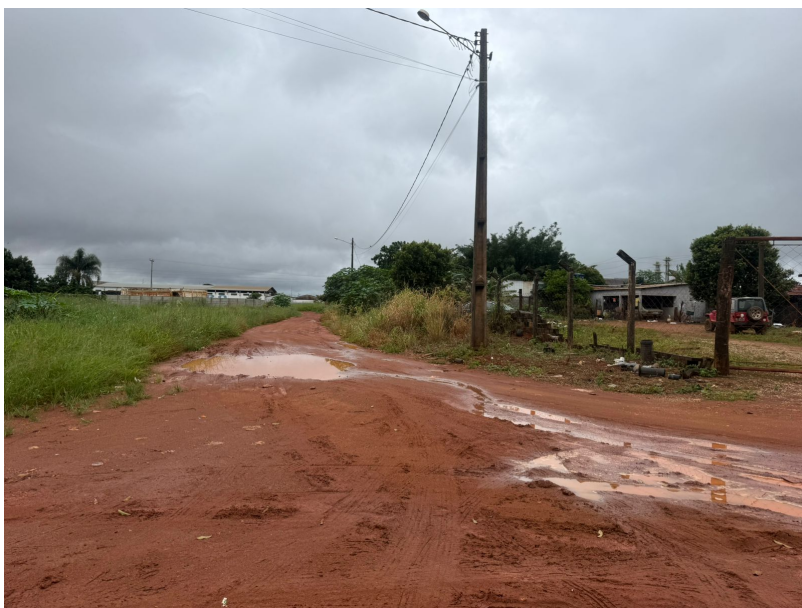
Imagem 05 - Via com acúmulo excessivo de água da chuva.
