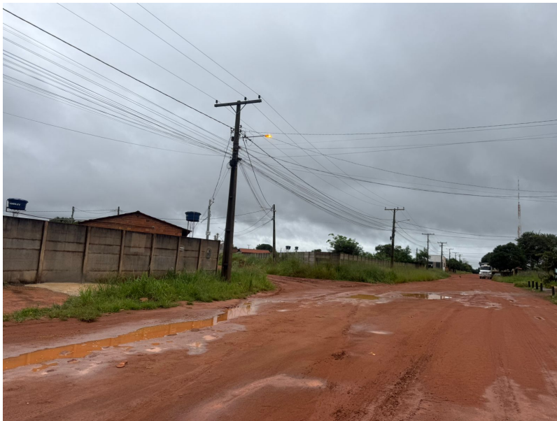
Imagem 07 - Rua não pavimentada e com escoamento de águas pluviais ineficiente.
