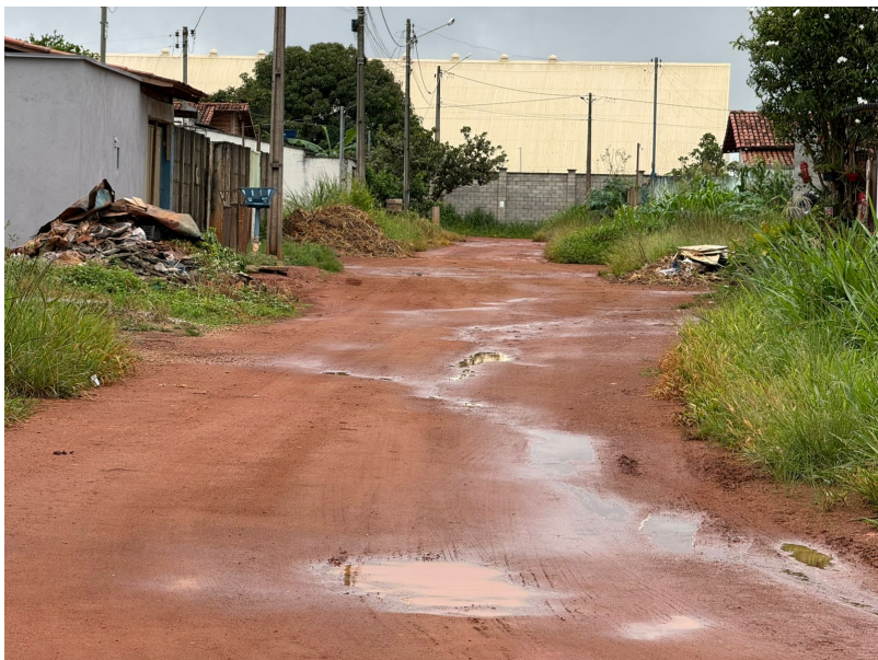
Imagem 06 - Via com acúmulo de águas pluviais e não pavimentada.
