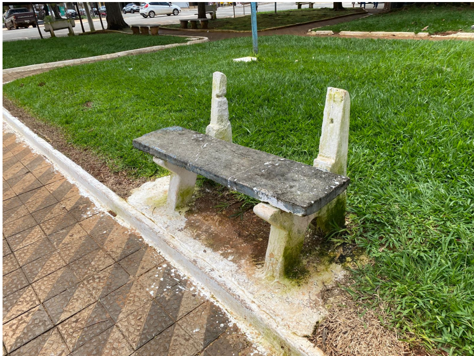
Imagem 05 - Mobiliário urbano quebrado e com peças soltas.
