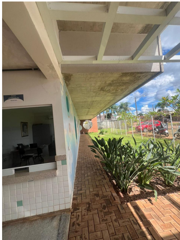
Imagem 1 - Situação atual dos elementos da parte externa - fachada frontal - da edificação.
