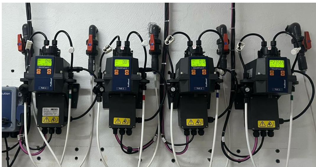
Imagem 01 – Válvulas PCV U no laboratório
