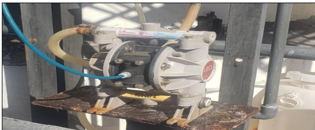
Figura 3 – Bombas dosadoras de diafragma existentes vistas no supervisório da ETA Cristo Rei
