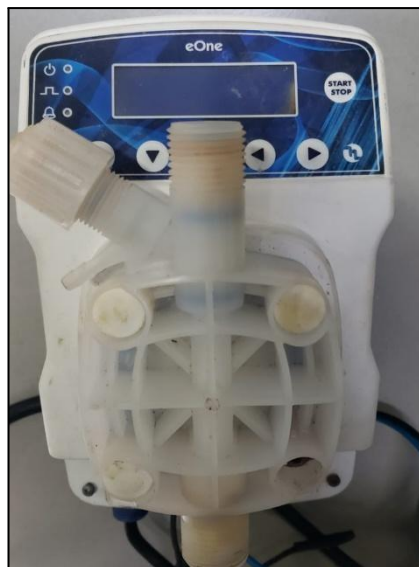
Figura 4 – Bomba dosadora de diafragma (Etatron eOne-MF) existentes na ETA Cristo Rei
