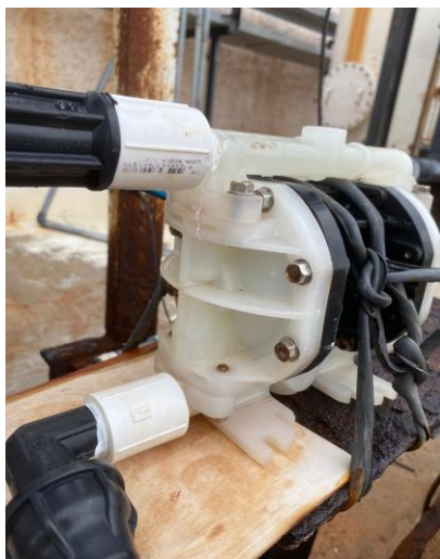
Figura 6 - Bomba SEKO de Polipropileno utilizado no CIP alcalino e CEB alcalino
