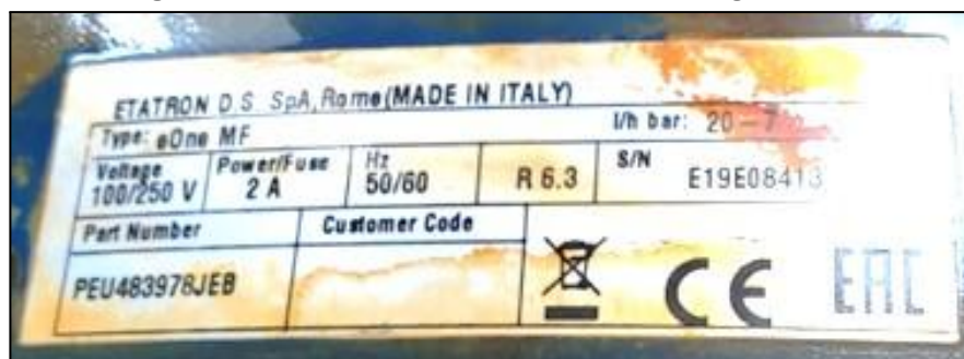
Figura 5 – Dados da bomba dosadora de diafragma
