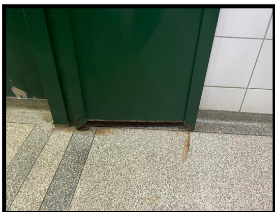
Imagem da porta e da tampa do ralo do banheiro danificada.
