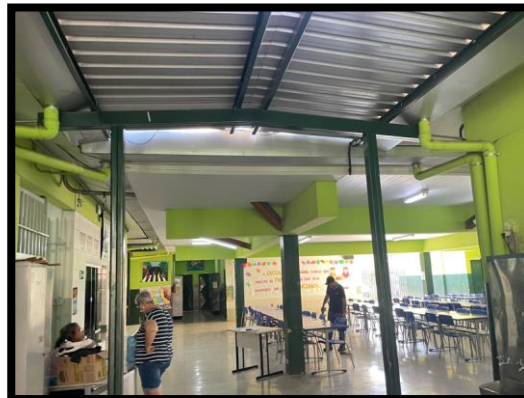
Imagem da iluminação insuficiente do pátio externo e imagem da passarela com ausência de rufos.
