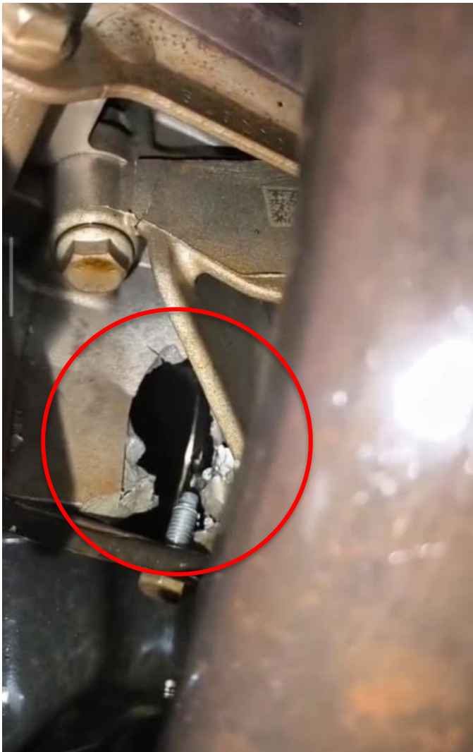
Imagem 01 – Furo na parte frontal do motor
