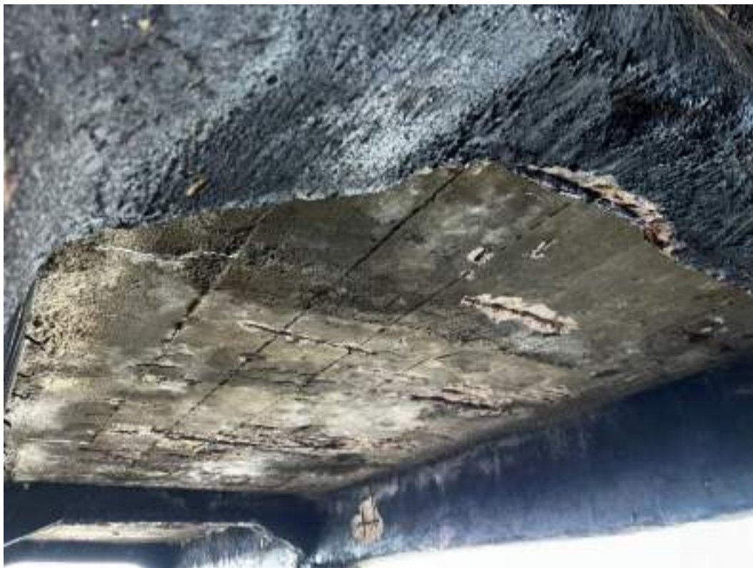
Foto 10 – Laje do Píer Fixo, executar obras de recuperação estrutural. Este serviço inclui demolição de concreto, substituição de armadura com tratamento anticorrosivo e concretagem.
