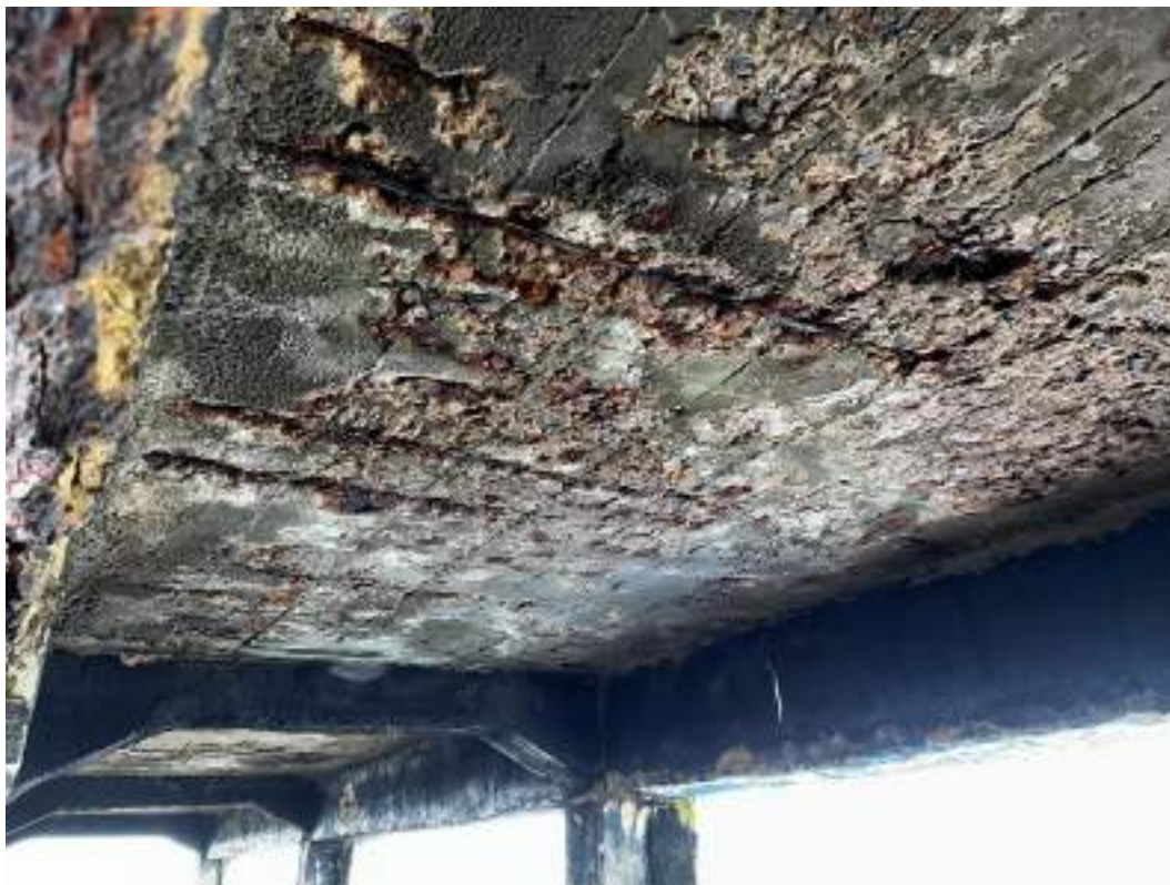
Foto 9 – Laje do Píer Fixo, executar obras de recuperação estrutural. Este serviço inclui demolição de concreto, substituição de armadura com tratamento anticorrosivo e concretagem.
