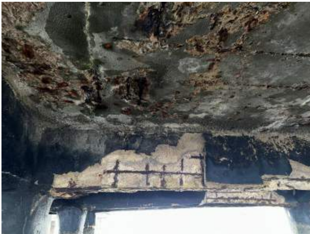
Foto 12 – Laje do Píer Fixo, executar obras de recuperação estrutural. Este serviço inclui demolição de concreto, substituição de armadura com tratamento anticorrosivo e concretagem.
