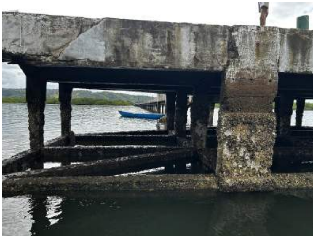
Foto 5 – Executar obras de recuperação estrutural dos pilares, vigas longitudinais, transversais e piso. Este serviço inclui demolição de concreto, substituição de armadura com tratamento anticorrosivo e concretagem.
