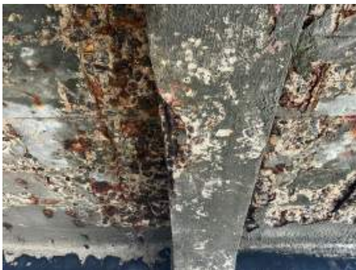
Foto 14 – Laje do Píer Fixo, executar obras de recuperação estrutural. Este serviço inclui demolição de concreto, substituição de armadura com tratamento anticorrosivo e concretagem.
