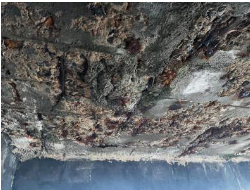
Foto 12 – Laje do Píer Fixo, executar obras de recuperação estrutural. Este serviço inclui demolição de concreto, substituição de armadura com tratamento anticorrosivo e concretagem.
