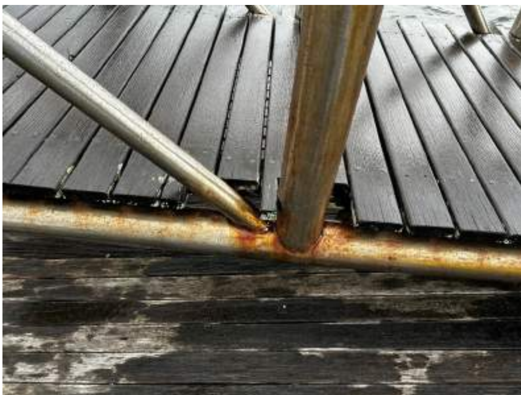
Foto 20 – Estrutura de aço inox a ser inspecionada.
