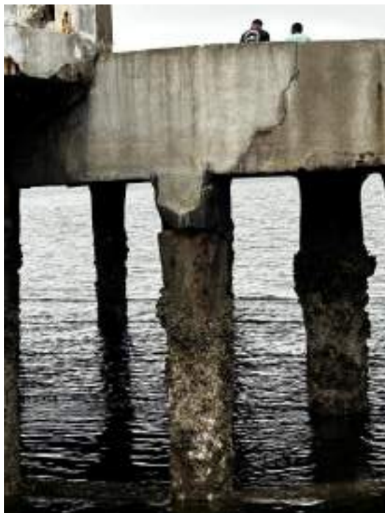
Foto 3 – Executar obras de recuperação estrutural dos pilares, vigas longitudinais, transversais e piso. Este serviço inclui demolição de concreto, substituição de armadura com tratamento anticorrosivo, instalação de formas e concretagem.
