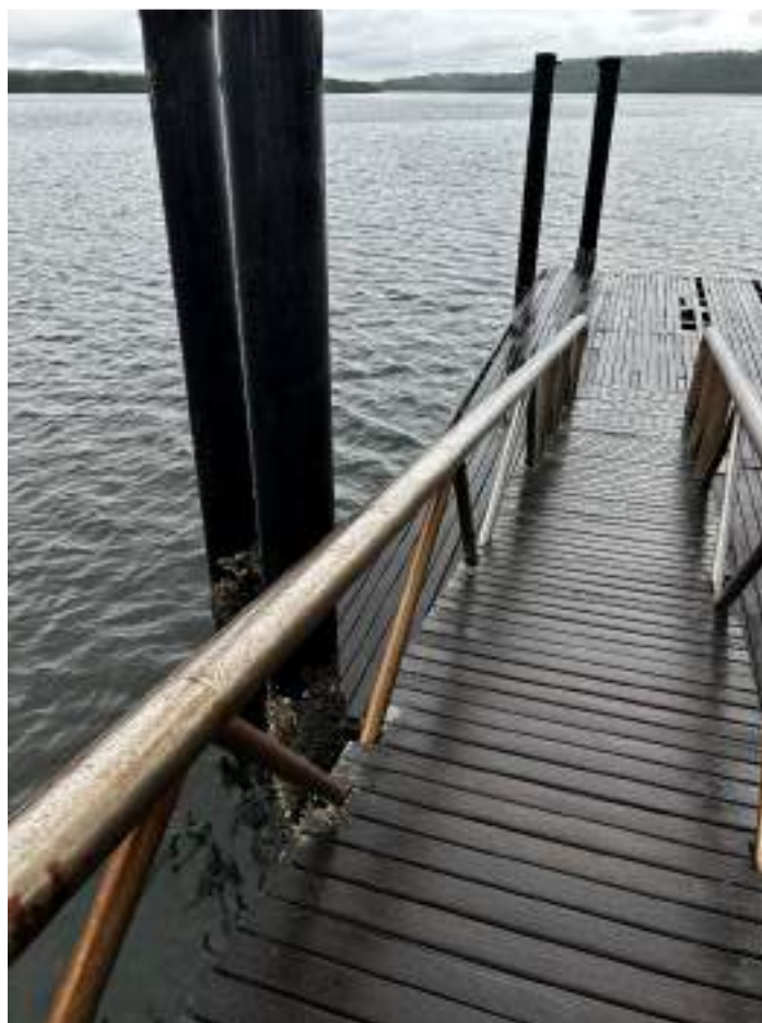
Foto 16 – Passarela Articulada e estacas guia
