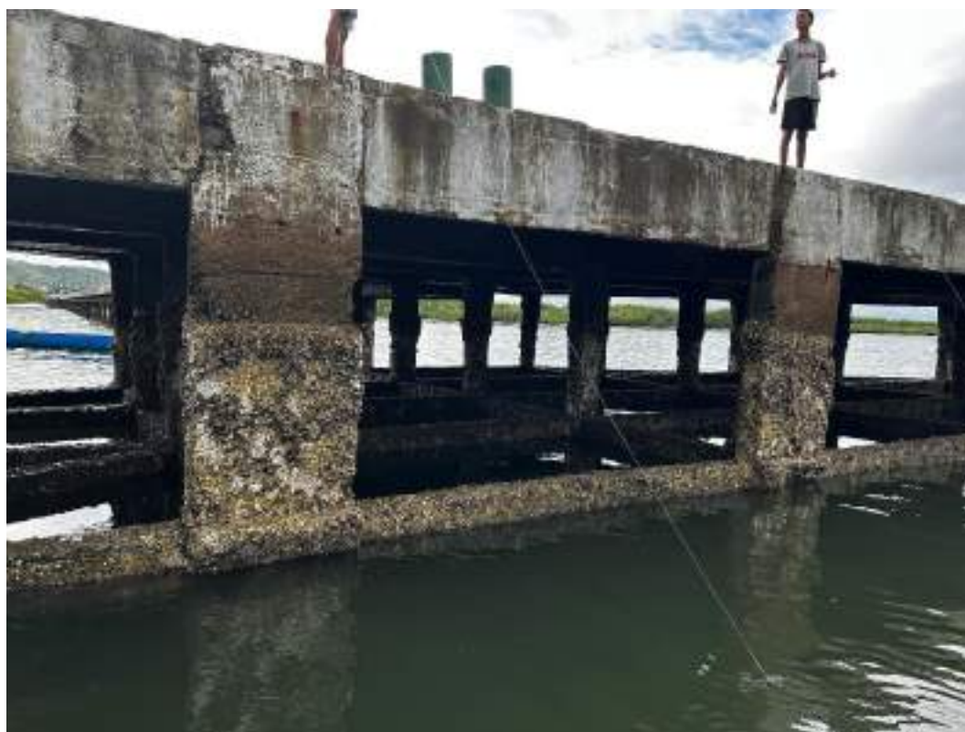
Foto 6 – Executar obras de recuperação estrutural dos pilares, vigas longitudinais, transversais e piso. Este serviço inclui demolição de concreto, substituição de armadura com tratamento anticorrosivo e concretagem.
