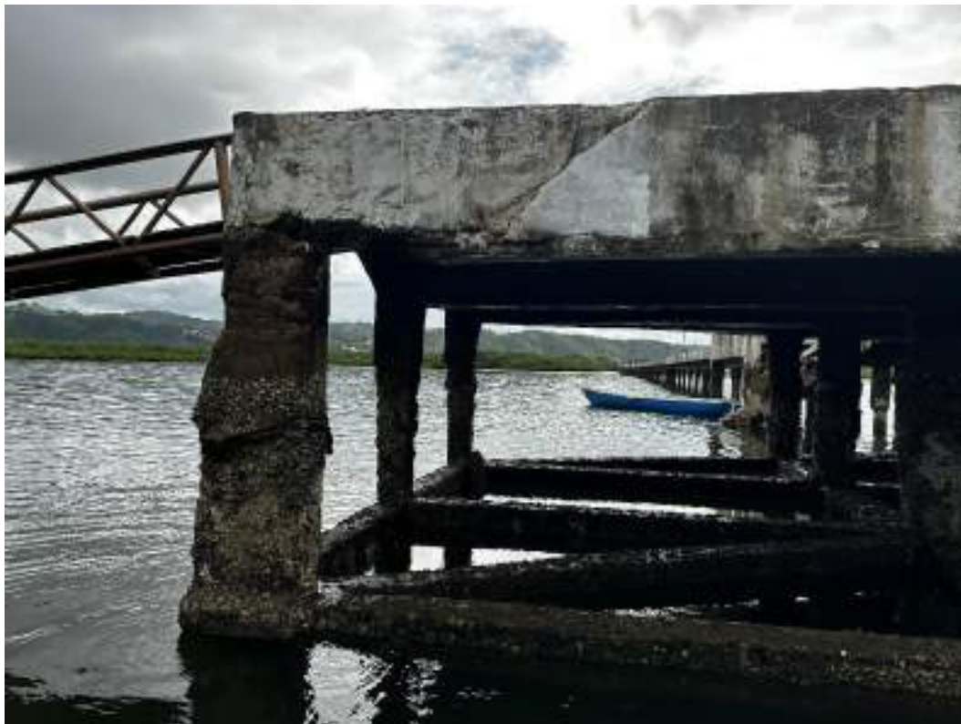
Foto 4 – Executar obras de recuperação estrutural dos pilares, vigas longitudinais, transversais e piso. Este serviço inclui demolição de concreto, substituição de armadura com tratamento anticorrosivo, instalação de formas e concretagem.
