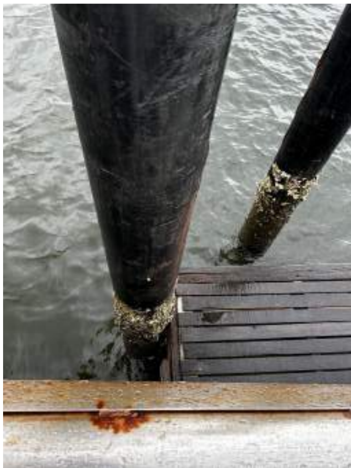
Foto 18 – Flutuante de atracação com piso a ser substituído
