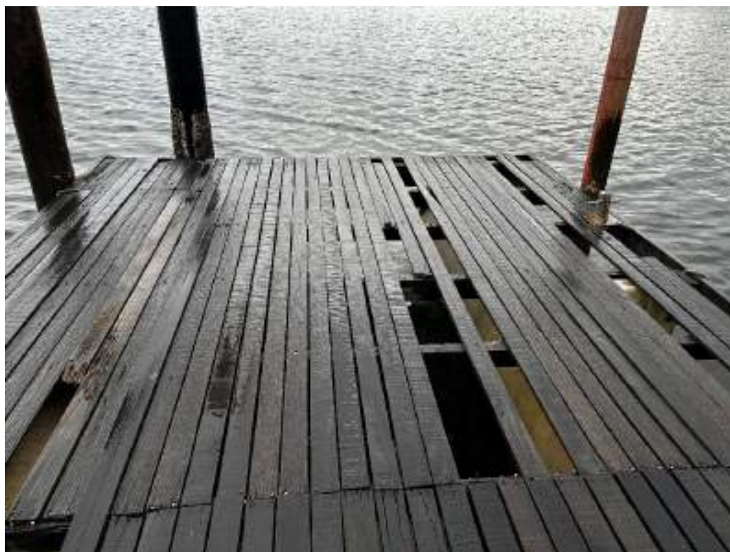
Foto 18 – Flutuante de atracação com piso a ser substituído
