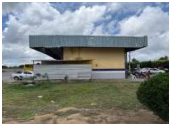
LOCALIZAÇÃO: Terminal rodoviário de Santo Estevão OCORRÊNCIA: Visita de inspeção
