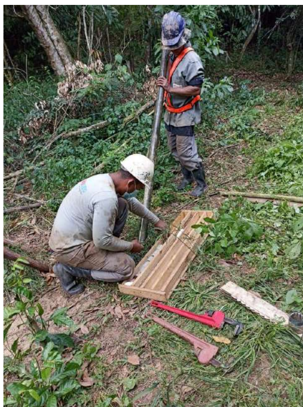
Figura 23 – Execução da sondagem mista (autoria própria, 2024)
