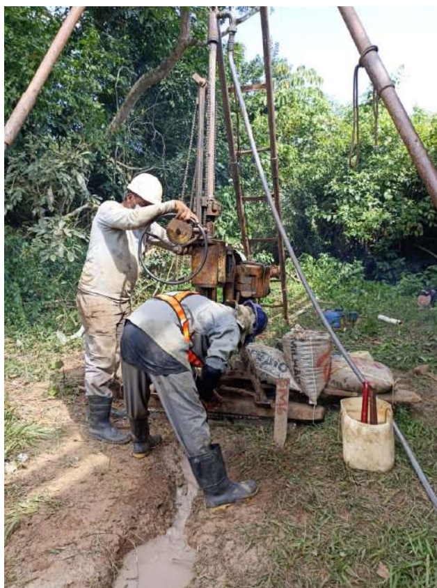
Figura 22 – Execução da sondagem mista (autoria própria, 2024)
