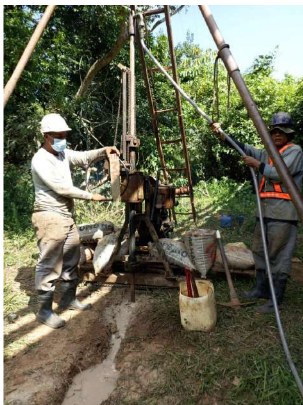
Figura 21 – Execução da sondagem mista (autoria própria, 2024)
