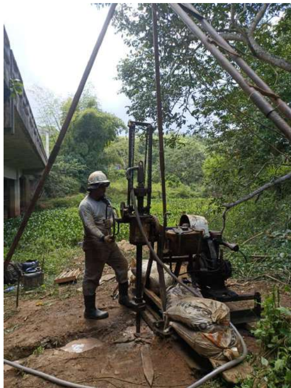
Figura 18 – Execução da sondagem mista (autoria própria, 2024)
