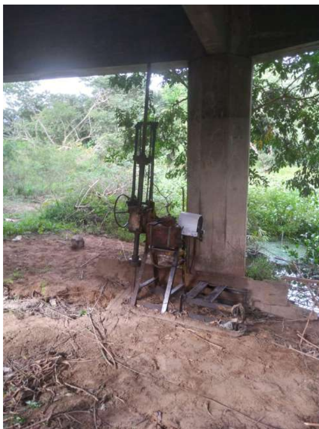
Figura 25 – Execução da sondagem mista (autoria própria, 2024)
