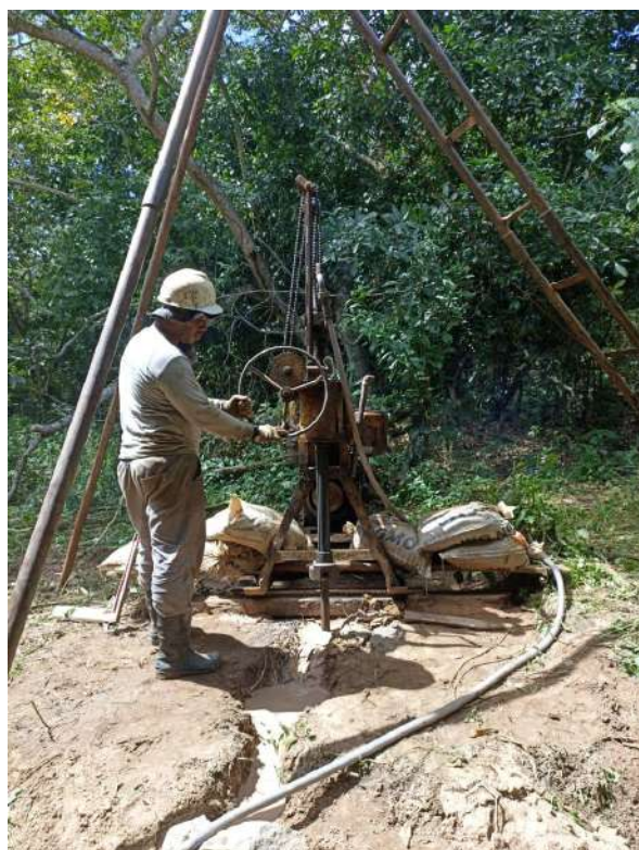
Figura 19 – Execução da sondagem mista (autoria própria, 2024)
