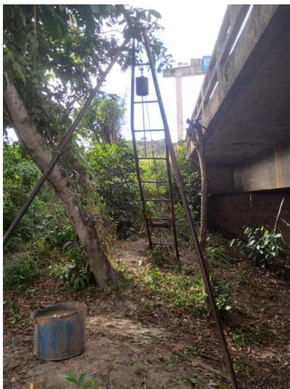
Figura 24 – Execução da sondagem mista (autoria própria, 2024)
