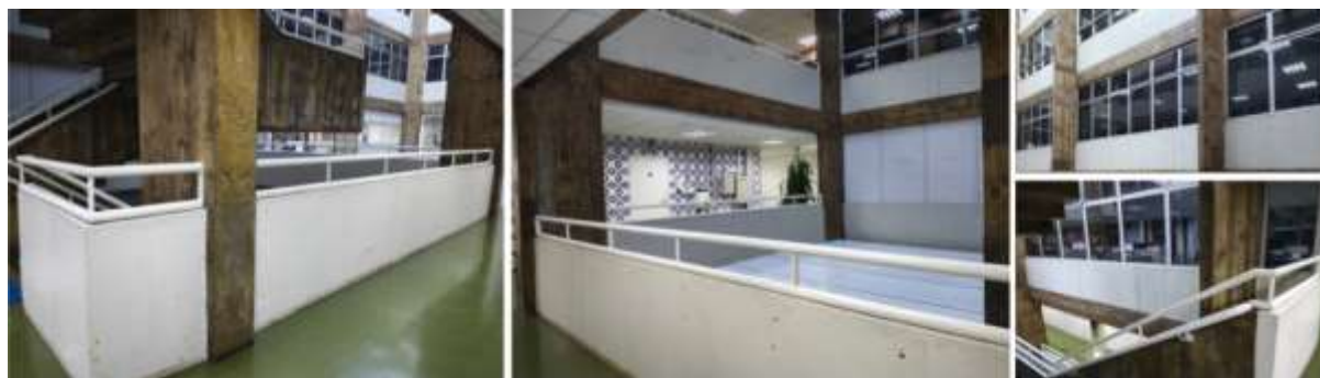
Imagens parciais das muretas e parapeitos que serão preparados e pintados
