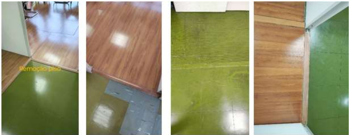
Remoção e descarte do piso instalado nos ambientes.
