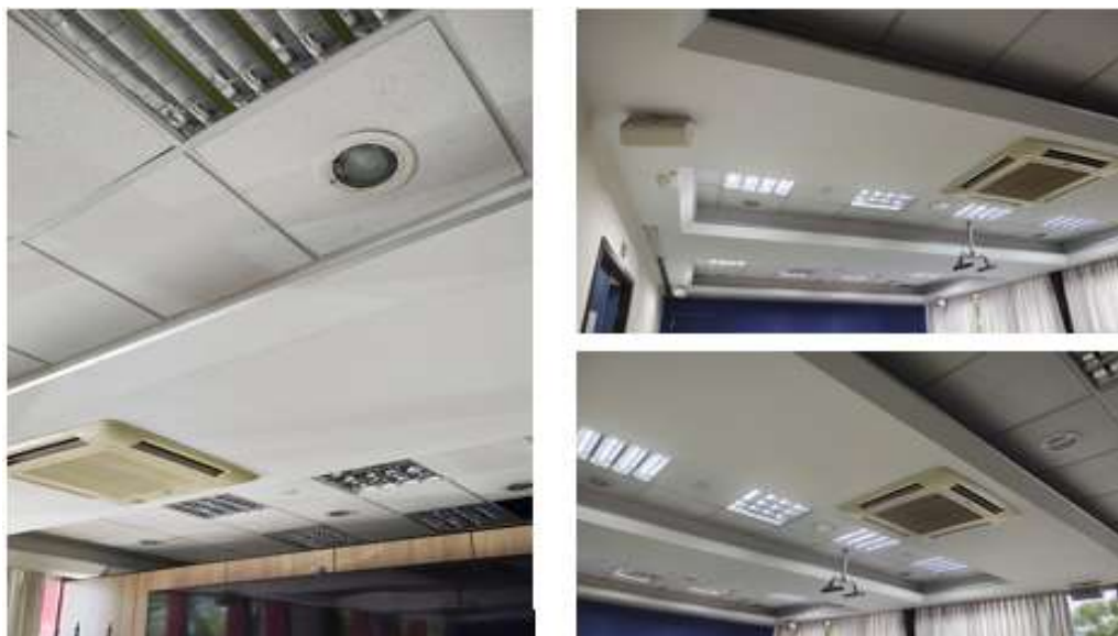
Remoção e descarte do forro instalado nas salas multiuso.
