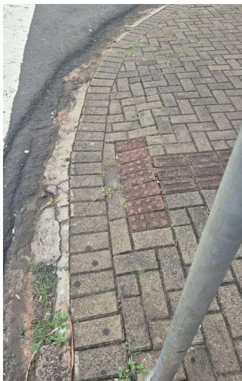
Foto 3 – Executar rampa de acessibilidade na esquina da Rua Pará
