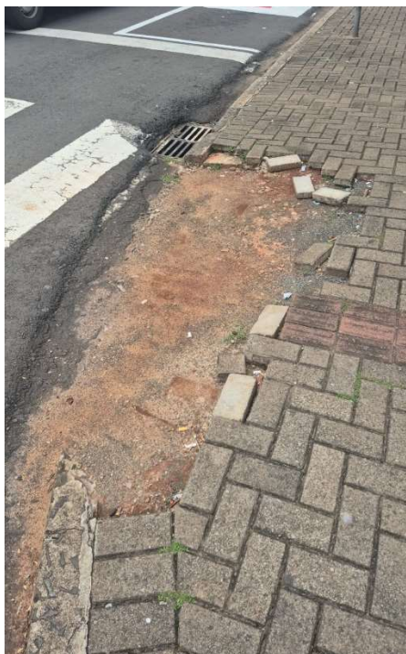
Foto 4 – Executar rampa de acessibilidade na esquina da Sen. Souza Naves
