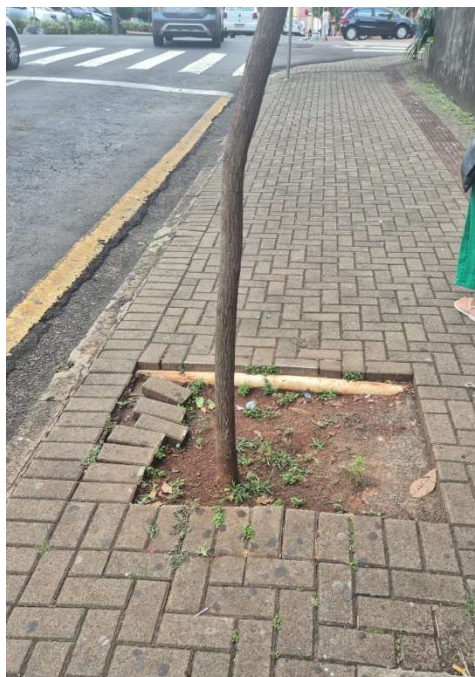
Foto 2 - Reinstalar blocos soltos e dar acabamento na tubulação aparente
