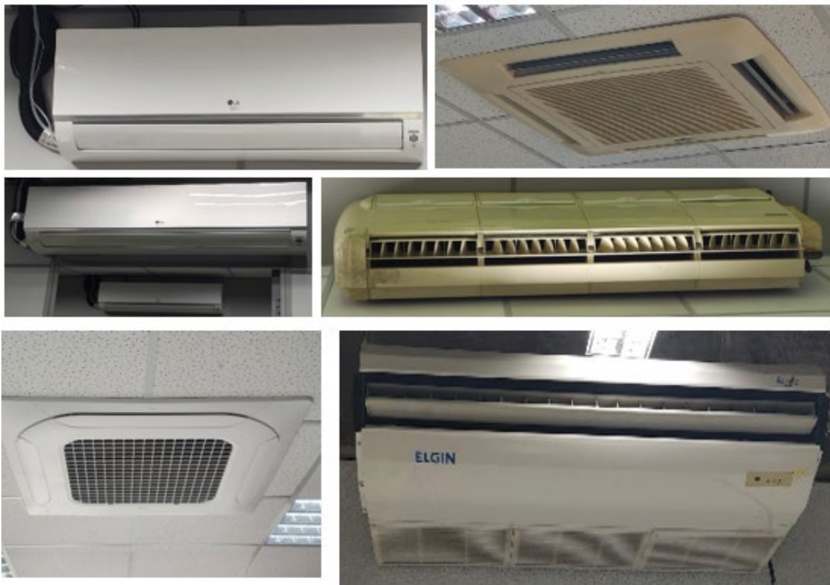
Exemplos de unidades evaporadoras que integram o sistema de climatização
