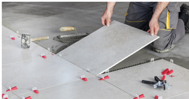
Figura 10 – Assentamento de piso cerâmico. Fonte: Embramarco.
