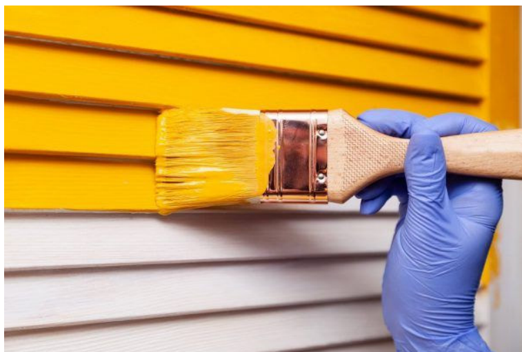
Figura 06 – Pintura de portas de madeira com uso de trincha. Fonte: Blog das cores.
