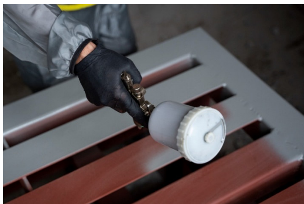
Figura 07 – Pintura de superfícies metálicas com compressor de ar. Fonte: Porto Gente.
