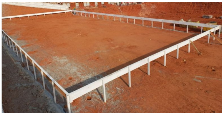
Figura 02 – Gabarito de Obra.
