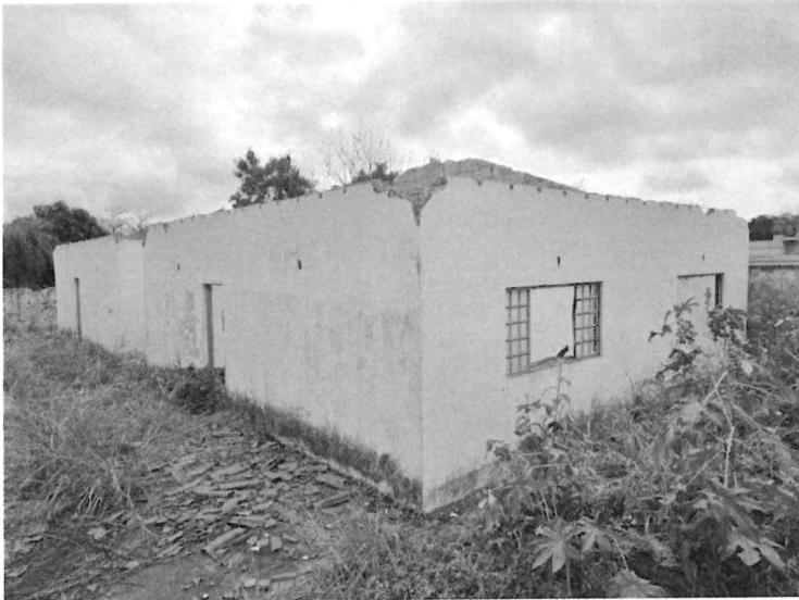
Limpeza do terreno – roçada e retirada de camada vegetal
