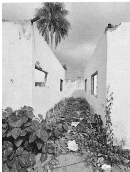
Instalação de esquadrias – Janelas metálicas completas
