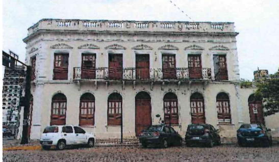
FACHADA SUL - RUA TREZE DE JUNHO. D: 02, 05, 07, 08, 10, 11, 12, 13, 21, 27
