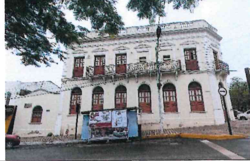
FACHADA OESTE - RUA XV DE NOVEMBRO.
