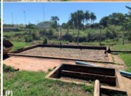
ETE SAUDADE: (A), (B) e (C) Sistema de Tratamento preliminar (calha Parshall, gradeamento e desarenador); (D) Almoarifado; (E) Reator Anaeróbio de Lodo Fluidizado (RALF), com destaque ao queimador de gases (não funcionando) e (F) Desarenador e Leito de Secagem.
