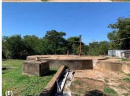
ETE SAUDADE: (A), (B) e (C) Sistema de Tratamento preliminar (calha Parshall, gradeamento e desarenador); (D) Almoarifado; (E) Reator Anaeróbio de Lodo Fluidizado (RALF), com destaque ao queimador de gases (não funcionando) e (F) Desarenador e Leito de Secagem.
