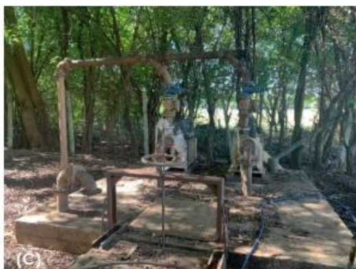
EEEB-02 – Palmito: (A) vista externa da área mostrando intensa cortina arbórea; (B), (C) e (D) Elevatória de Esgoto bruto que recalcam para a ETE Juracy Lucas.
