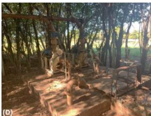
EEEB-02 – Palmito: (A) vista externa da área mostrando intensa cortina arbórea; (B), (C) e (D) Elevatória de Esgoto bruto que recalcam para a ETE Juracy Lucas.
