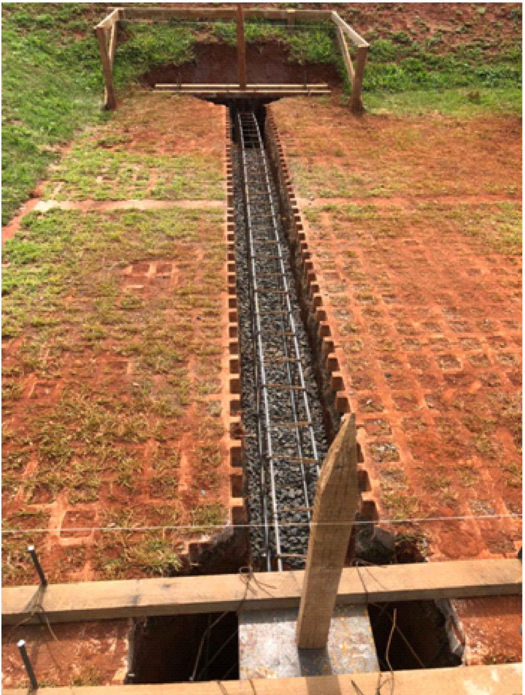
ILUSTRATIVO DETALHE DA FUNDAÇÃO
