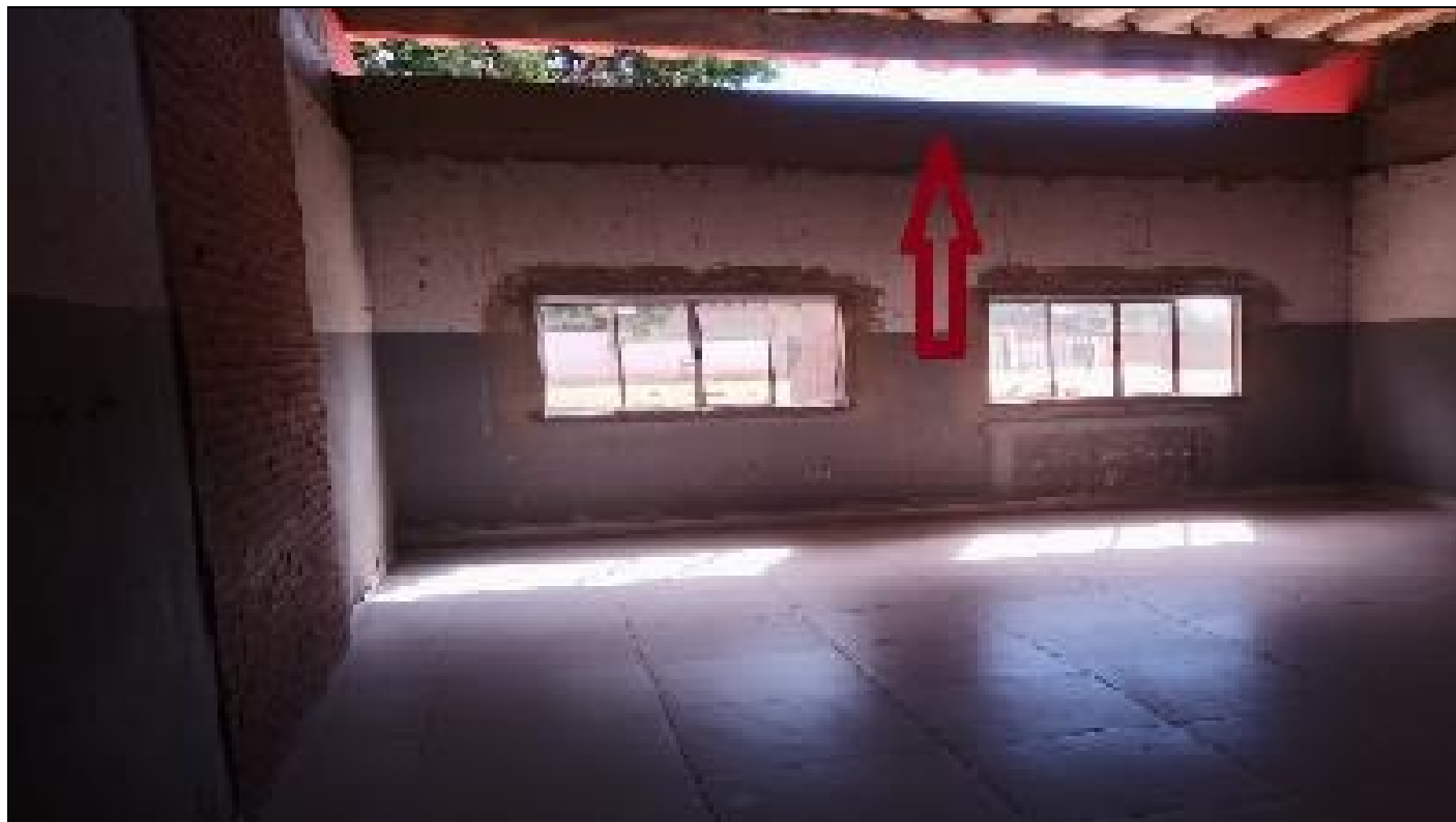
Imagem 02: Sala de convivência – local onde será colocado o forro.
