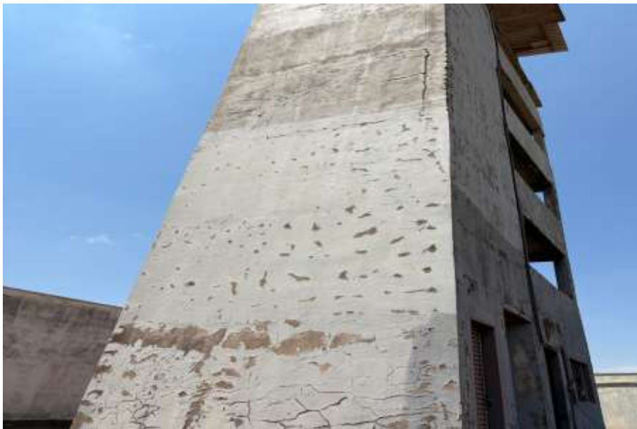
Vista 5 - Fachada frontal da torre – estado geral externo.
