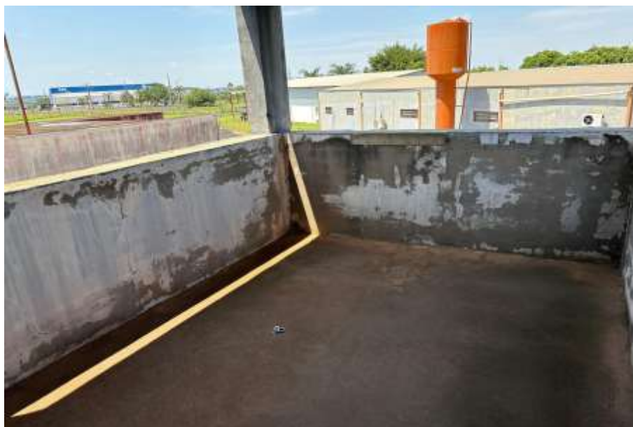
Vista 9 - Detalhe interno lateral da torre.
