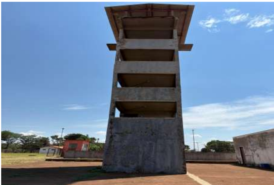
Vista 1 – condição inicial do estado de pintura e revestimento.
