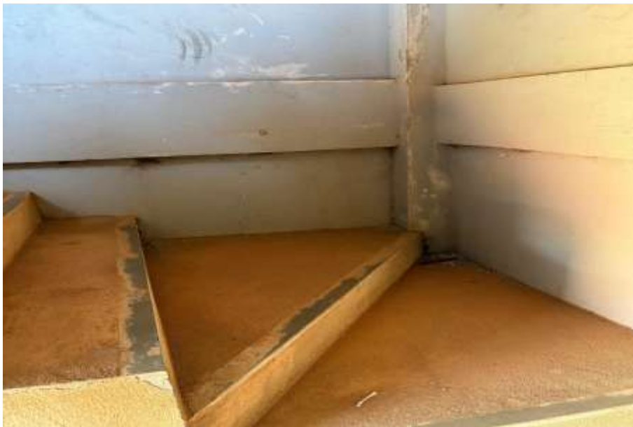
Vista 7 - Acesso inferior da torre com escada de chegada.
