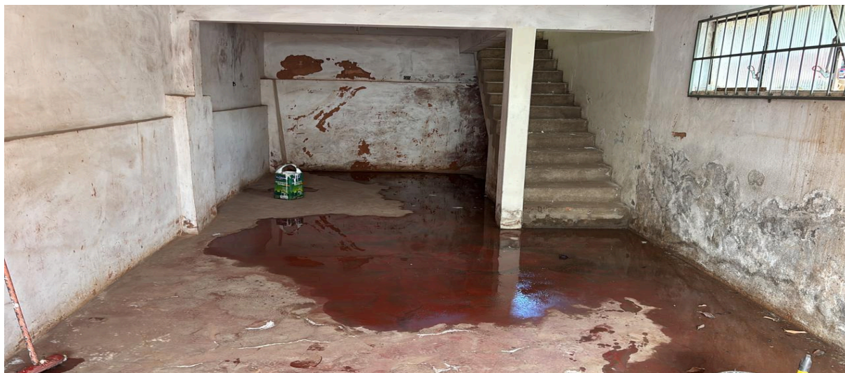
Imagem 06 – Subsolo da Edificação
