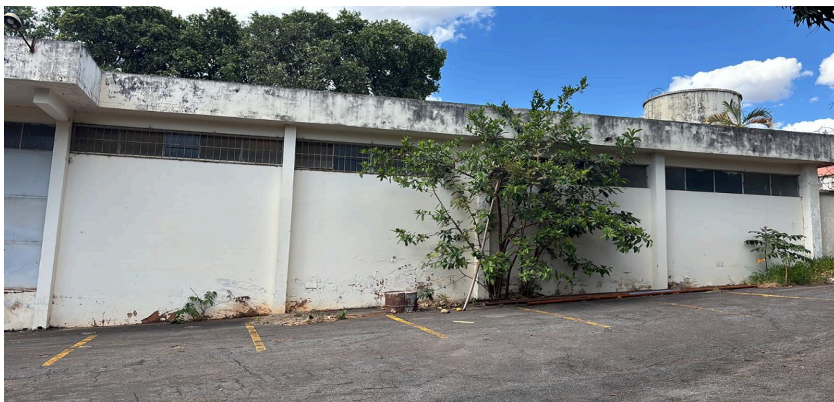
Imagem 02 – Fachada Lateral da Edificação
