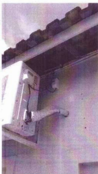
Figura 1 - Circuito externo (aéreo) com disjuntor entrada com distribuição
