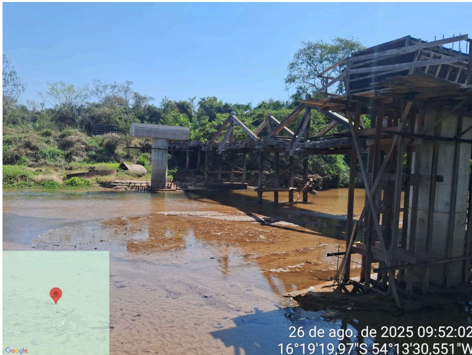
Figura 1: Ponte de Maderia
