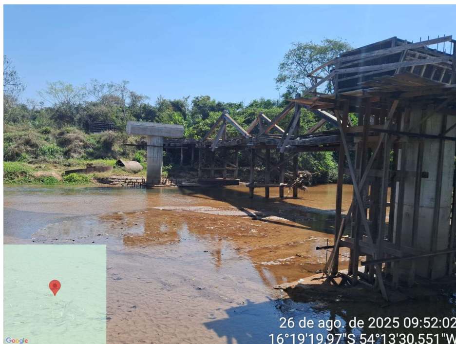
Figura 1: Ponte de Maderia
