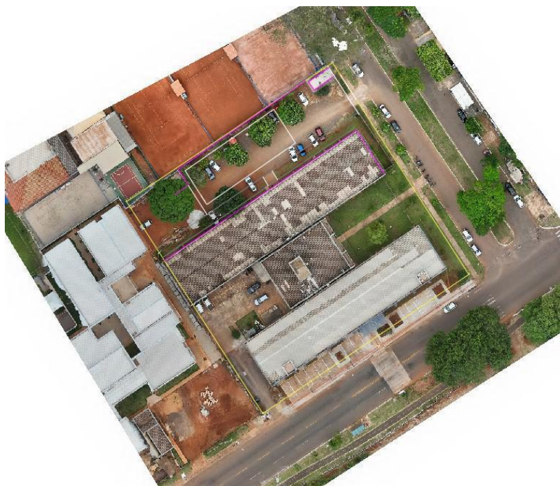
Figura 1 – Local de implantação Oficina Ortopédica
