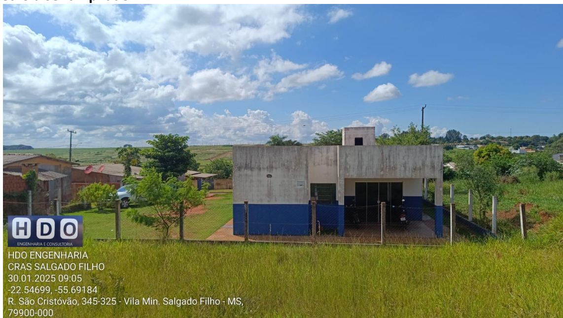
Imagem 02 – Local de Intervenção
