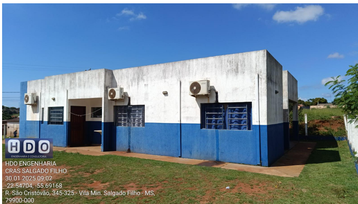
Imagem 03 – local de intervenção
